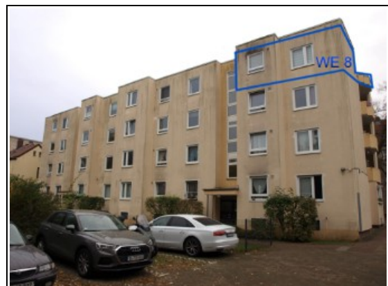
hofseitige Ansicht mit SE Nr. 8 im 3. OG aus Richtung Nordwest
