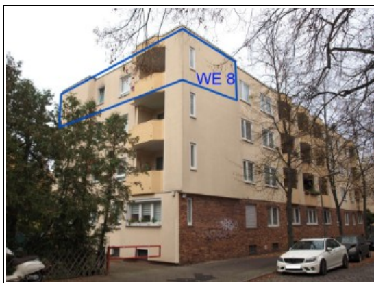
straßenseitige Ansicht mit SE Nr. 8 im 3. OG aus Richtung Südwest
