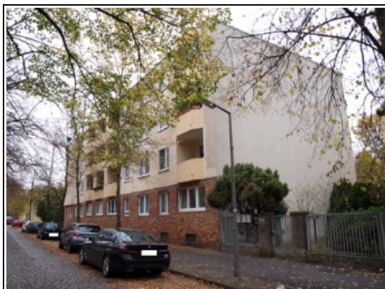
straßenseitige Ansicht der Wohnanlage Raschdorffstraße 31, 33 aus Richtung Osten
