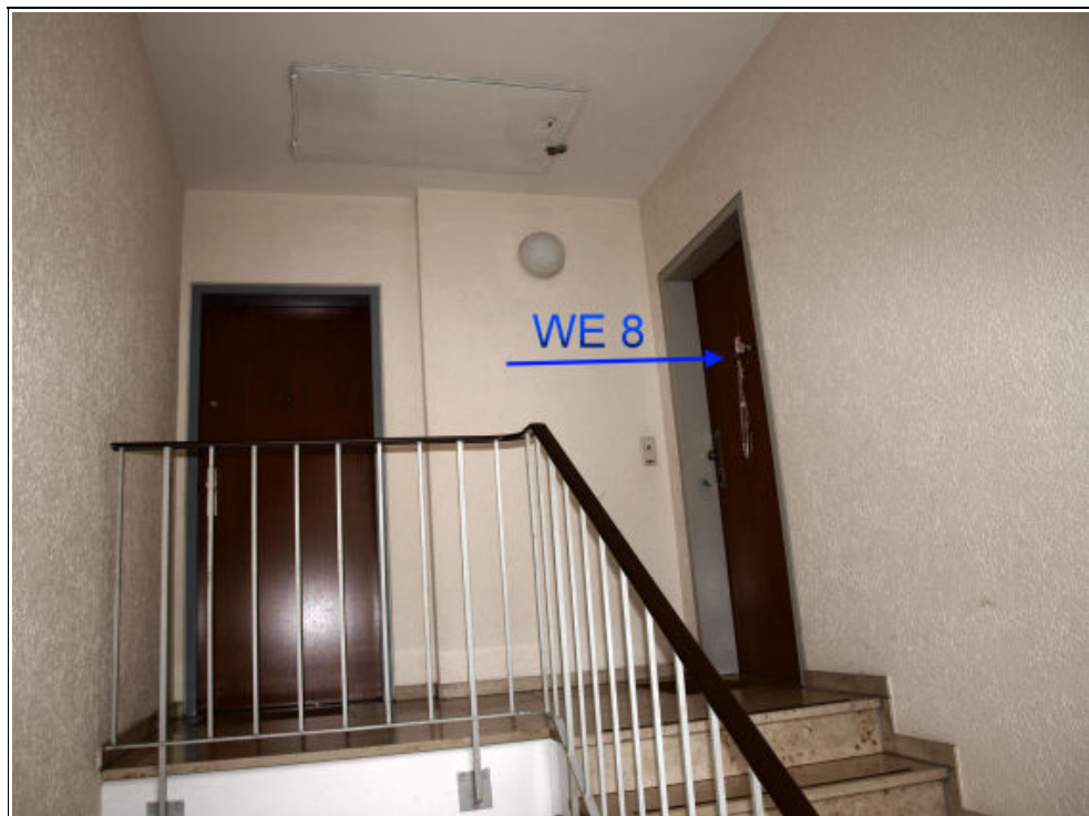
Abbildung 13: Ansicht des Wohnungszugangs von SE Nr. 8 im 3. OG
