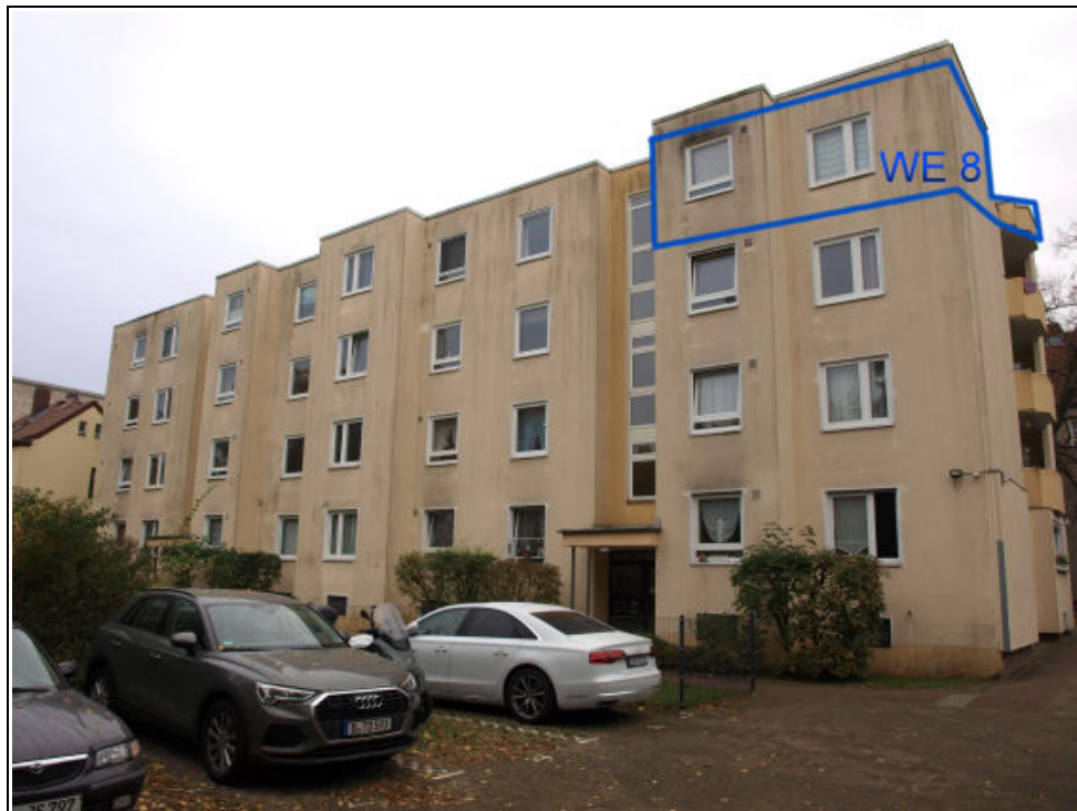
Abbildung 9: hofseitige Ansicht mit SE Nr. 8 im 3. OG aus Richtung Nordwest
