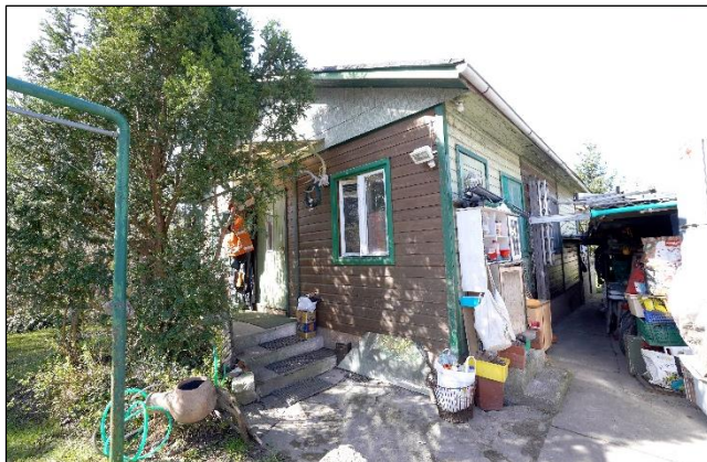
Ostansicht Wochenendhaus, Eingangsseite
