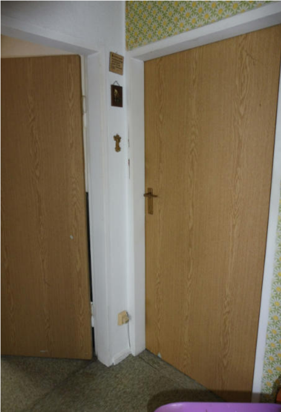
Flur im OG
