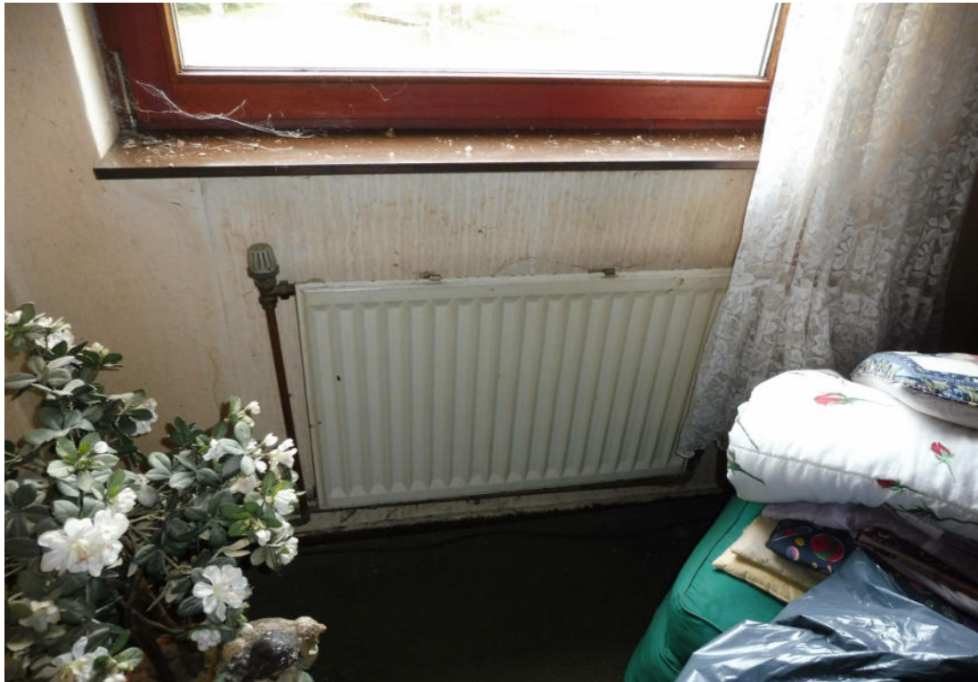
Fensterbrüstung in einem Wohnraum
