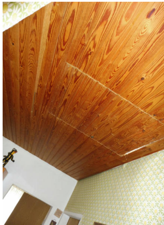
Flur im OG mit Schornsteinfegerausstieg
