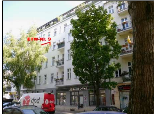
Gebäudefront zur Jablonskistraße mit WE 9
