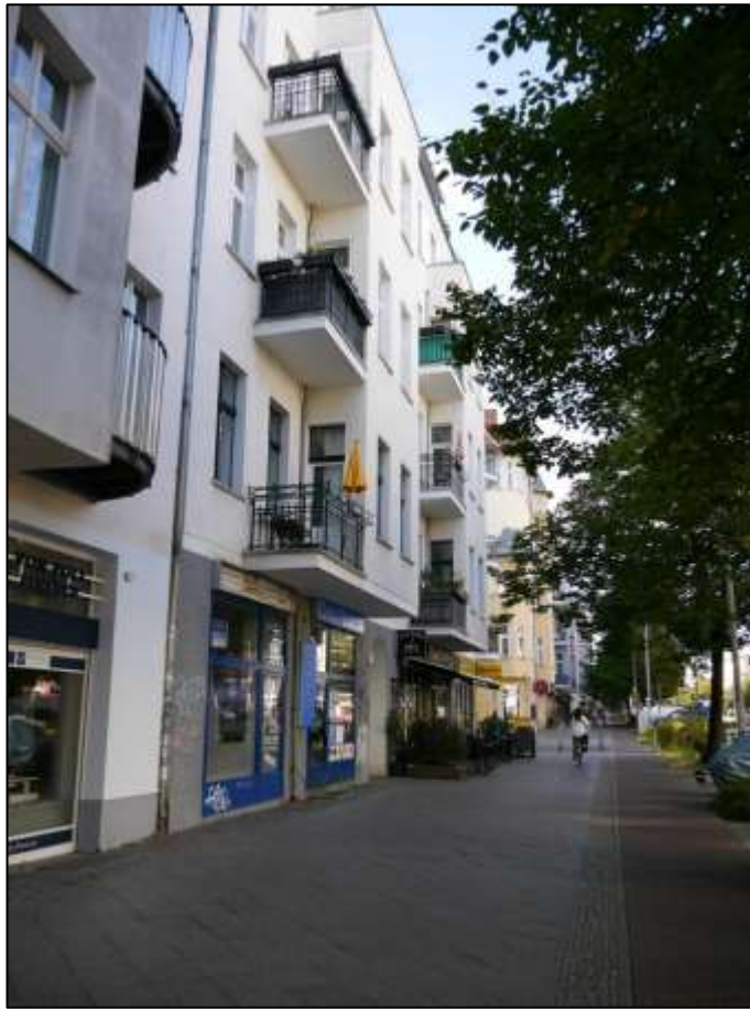
zur Prenzlauer Allee orientierte Straßenfront des auf dem Eckgrundstück Prenzlauer Allee 51, Jablonskistr. 21 aufstehenden Gebäudekomplexes
