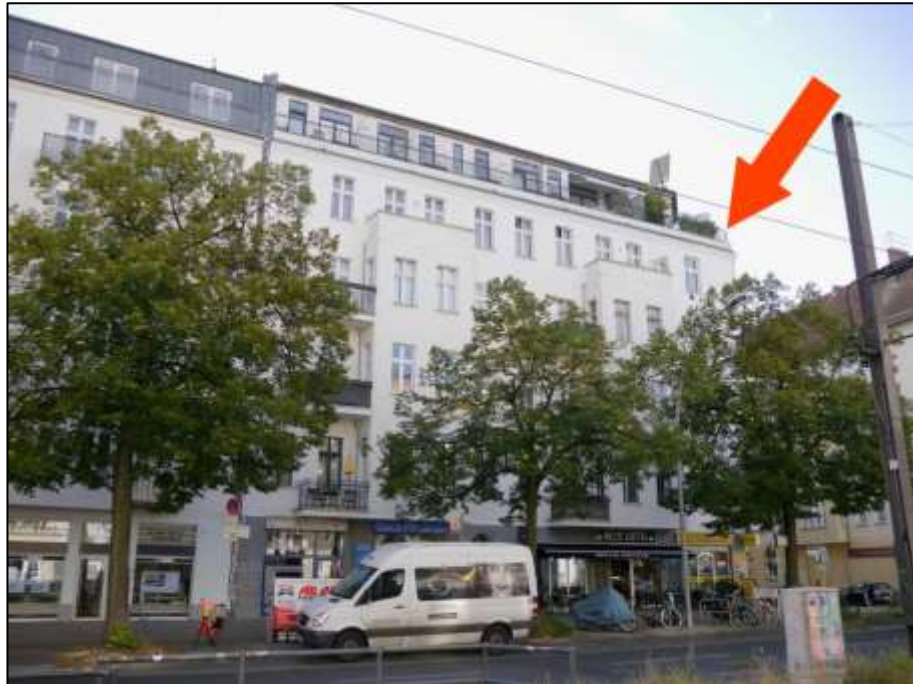
Blick über die Prenzlauer Allee nach Süd-Osten mit Lage des Eckgrundstücks Jablonskistraße 21, Prenzlauer Allee 51 auf der östlichen Straßenseite (Pfeil)
