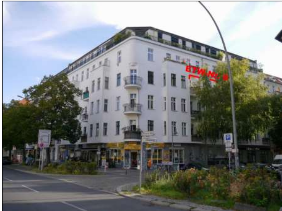
Eckgrundstück Jablonskistraße 21, Prenzlauer Allee 51 mit Blick aus der Prenzlauer Allee und Lage der ETW-Nr. 9 im 3.OG des Vorderhauses Jablonskistr. 21
