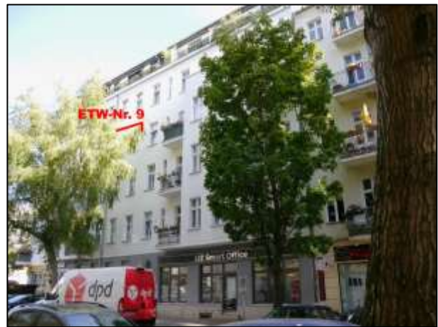
Gebäudefront zur Jablonskistraße mit WE 9
