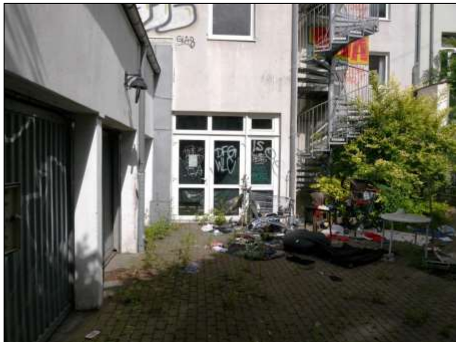
vordere Garagenfront mit Einfahrtstoren und im Hintergrund anbinden-des Hotelgebäude mit Frühstückraum
