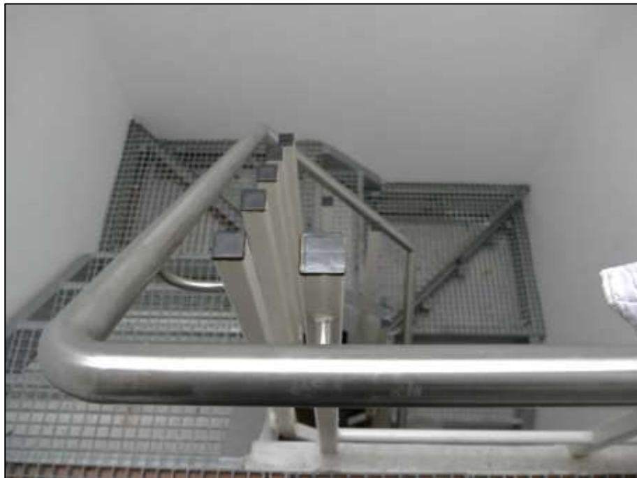
Treppenaufgang aus dem Dachgeschoss zum Dachboden
