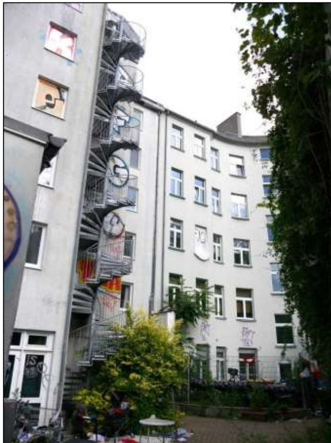
Blick über den Hof in Richtung des nord-östlich angrenzenden Nachbargrundstück mit rechts im Bild zum Bahndamm aufgehender Stützwand - Stahlspindel-Fluchttreppe vor der hofseitigen Front des Hotelgebäudes links im Bild
