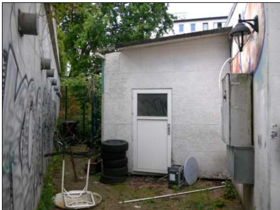
Holzschuppen-Anbau an den Garagentrakt vor der zum Bahndamm aufgehenden Stützwand (links im Bild)
