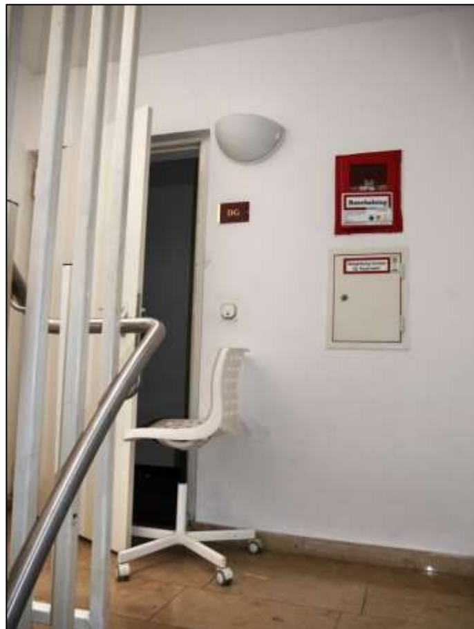
Treppenaustritt in das Dachgeschoss
