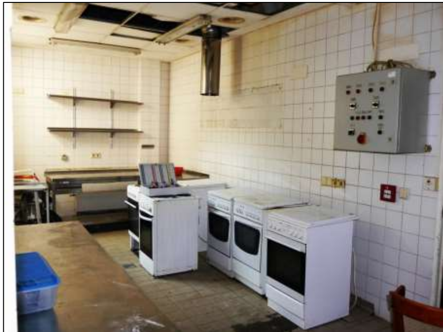
Zubereitungsküche im Erdgeschoss
