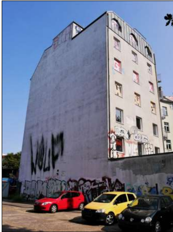
freie Giebelseite und hofseitige Front des auf dem Grundstück Gürtelstr. 41 aufstehenden Hotelgebäudes mit Blick von dem süd-westlich angrenzenden Nachbargrundstück Gürtelstr. 40
