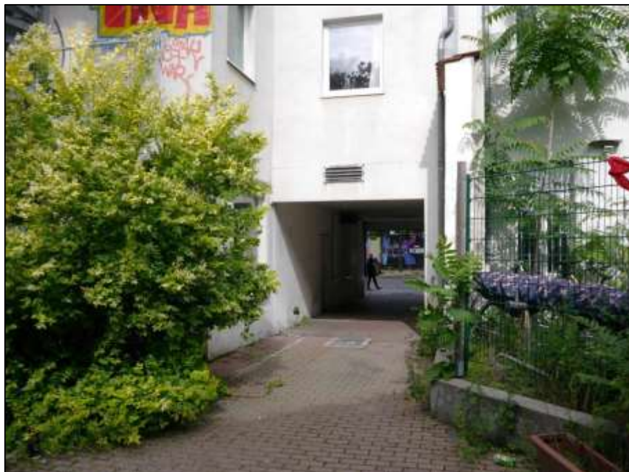
Blick aus dem Hof auf die unterkellerte Gebäuedurchfahrt auf dem Grundstück Gürtelstr. 41 mit Nebeneingängen zur Küche und Lounge
