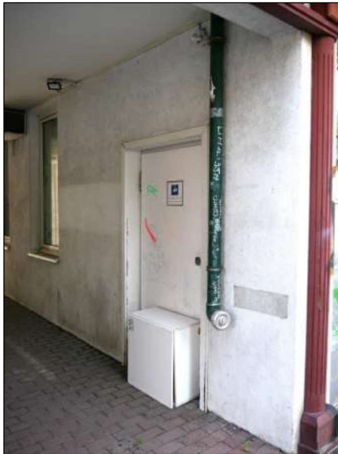
unterkellerte Gebäuedurch- fahrt von der Straße aus zu dem rückwärtig auf dem Grund- stück Gürtelstr. 41 belegenen Hof mit Neben- eingang zur Lounge
