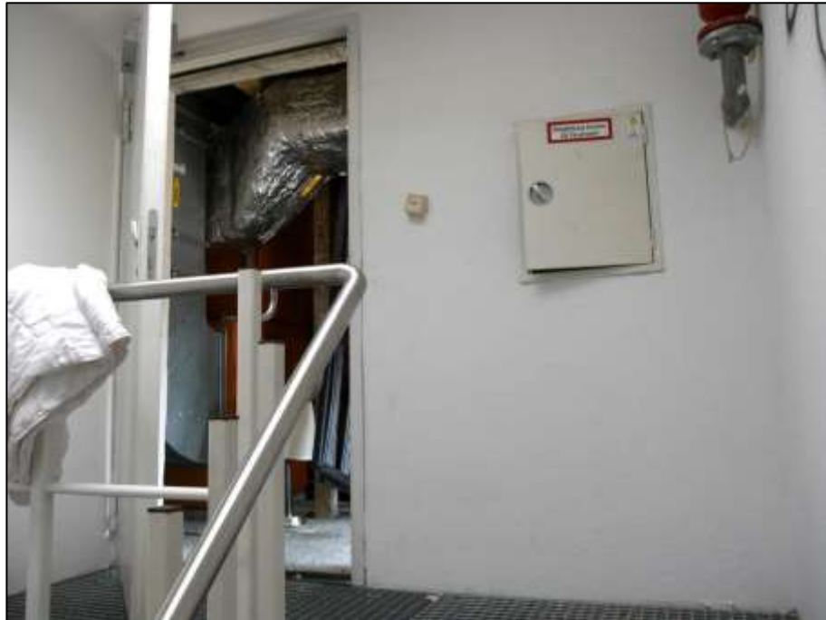
Treppenaustritt im Treppenhauskopf vor dem Dachboden
