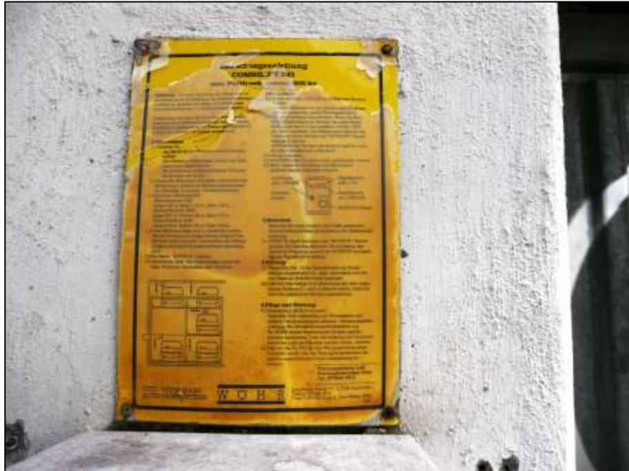
vordere Garagenfront mit Nutzungsanleitung für das Parkliftersystem nebst Schiebebühne für 8 PKW
