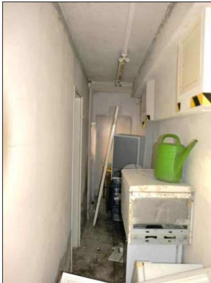
Vorflur zu weiteren Keller-räumen
