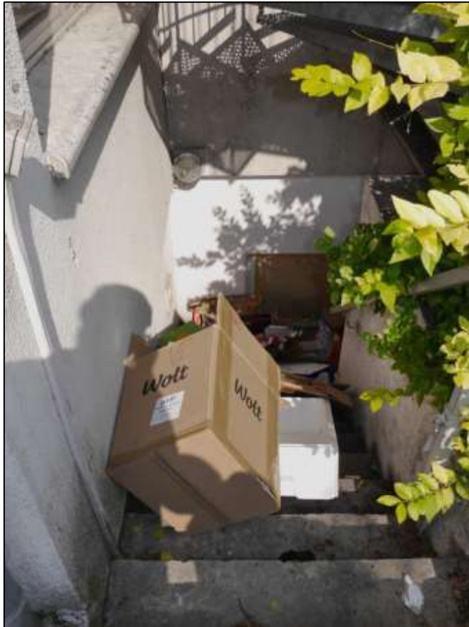
hofseitige Kelleraußentreppe unmittelbar hinter der hofseitigen Gebäudefront
