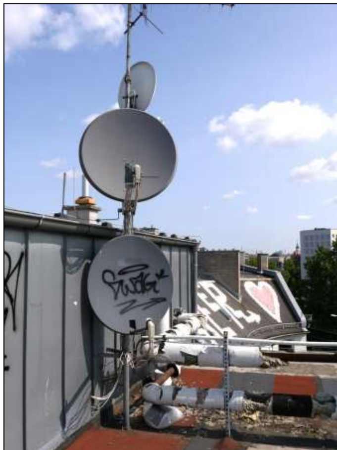
auf der hofseitigen Plateaufläche über dem Dachgeschoss an der aufgehenden Front des Dachbodenaufbaus verwahrter Parabol-Antennenträger
