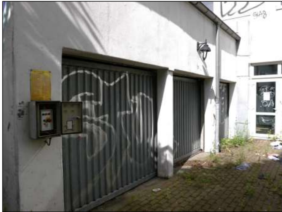
vordere Garagenfront mit Einfahrtstoren und Steuerung des Parklifter-systems nebst Schiebebühne für 8 PKW - im Hintergrund rechts an-bindendes Hotelgebäude
