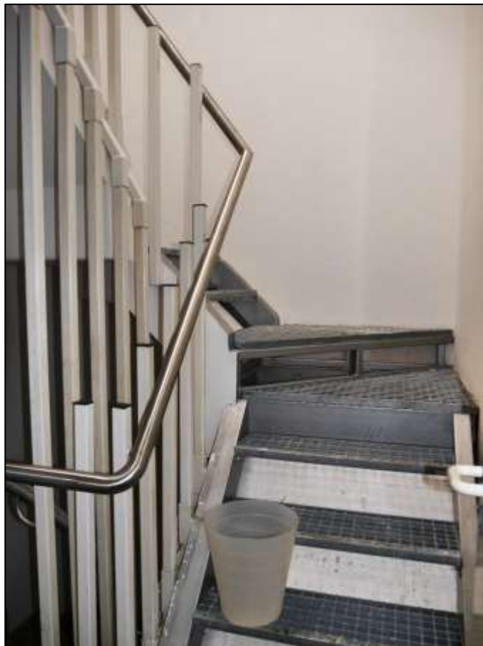
Treppenaufgang aus dem Dachgeschoss zum Dachboden
