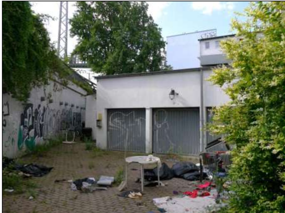
an das Hotelgebäude im Bereich des Erdgeschosses rückwärtige anbindender Garagen-Anbau mit Parkliftersystem nebst Schiebebühne für 8 PKW und Holzschuppen-Anbau vor der zum Bahndamm aufgehenden Stützwand links im Bild
