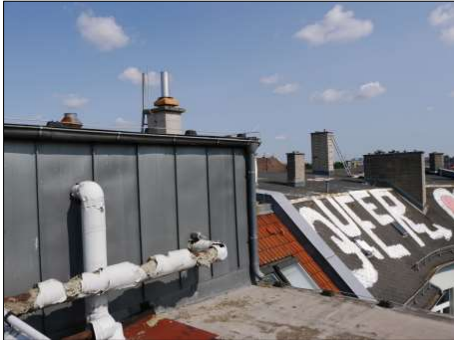
rückwärtige Gebäudefront im Bereich des Bodenraums über dem Dachgeschoss
