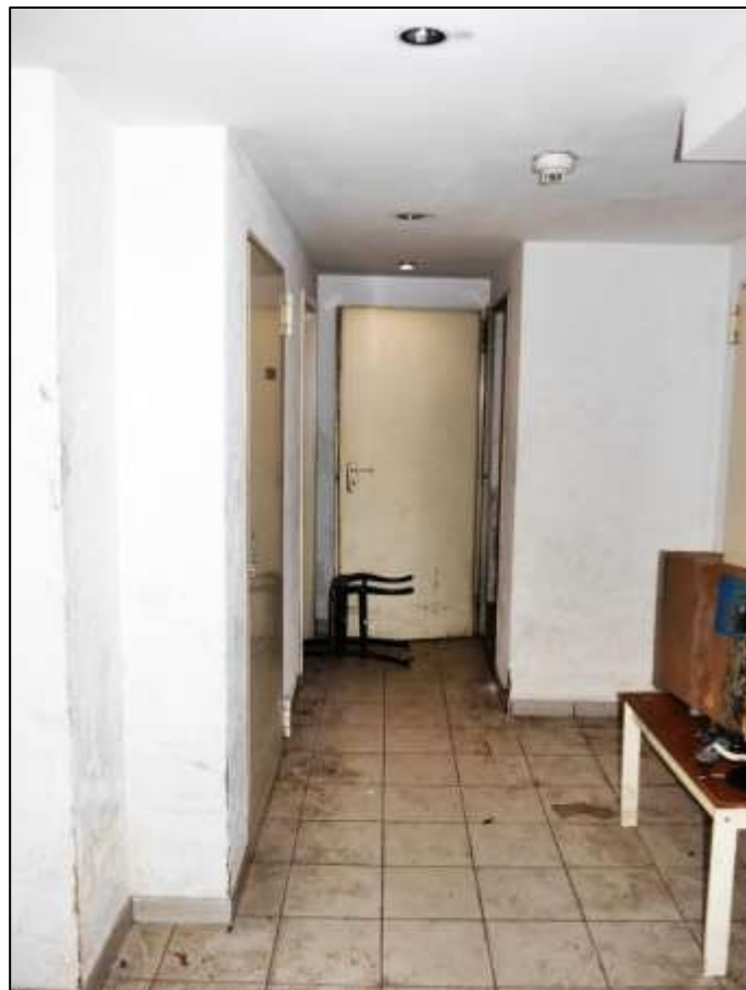
Kellerflur mit anbindendem Aufzug und geschlechtsspezifisch getrennten Toilettenräumen
