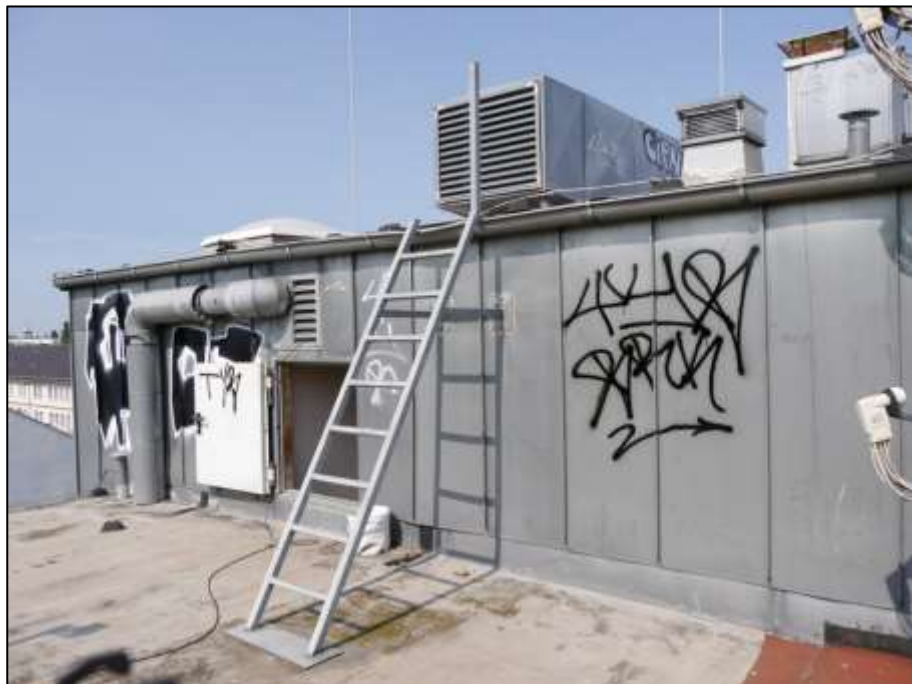
rückwärtige Gebäudefront im Bereich des Bodenraums über dem Dachgeschoss mit Ausstiegsluke und Anstalleiter auf die darüber belegene Plateaufläche
