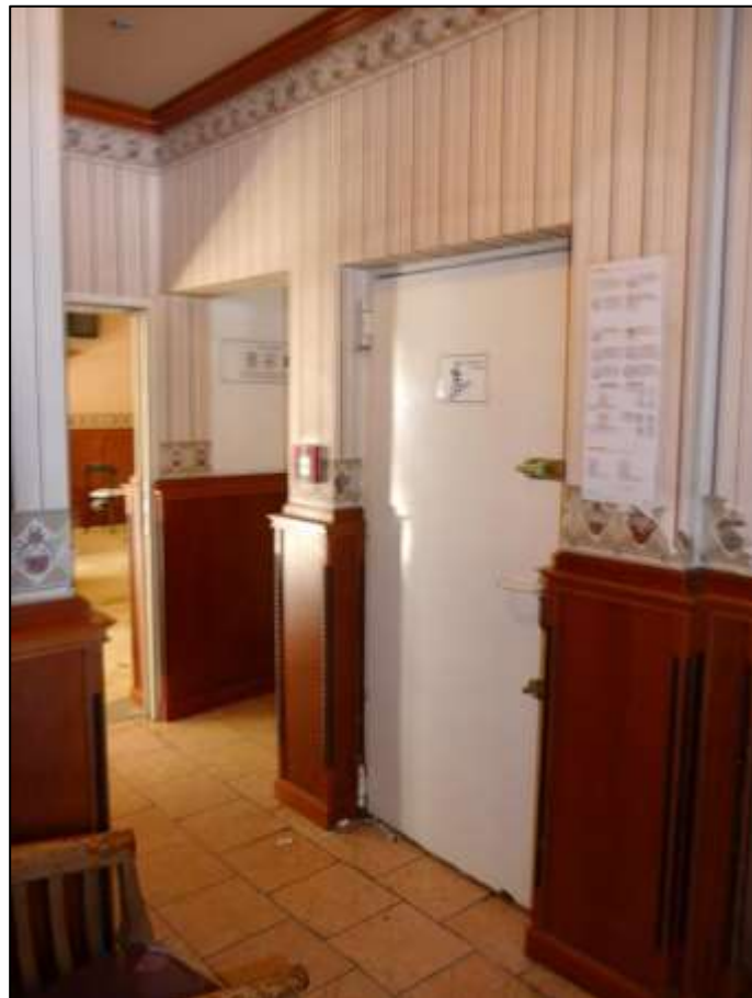
Zugangstür zum innenliegenden Treppenhaus in die Obergeschosse und dahinter offen anbindender Kellertreppenabgang und Frühstücksraum links im Hintergrund
