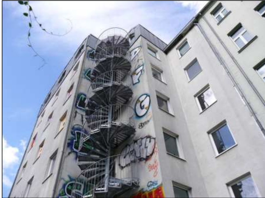
hofseitige Front des Hotelgebäudes mit davor verbauter Stahlspindel-Fluchttreppe
