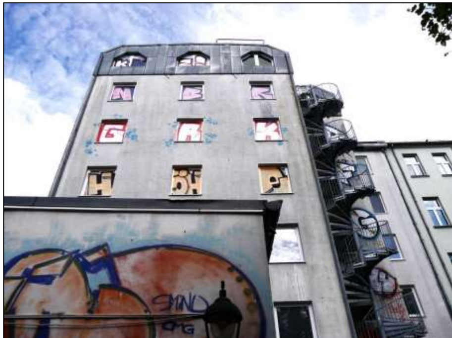
hofseitige Front des Hotelgebäudes mit Blick aus dem Bereich vor der rückwärtigen Giebelseite des Garagen-Anbaus mit recht im Bild angebaute Stahlspindel-Fluchttreppe
