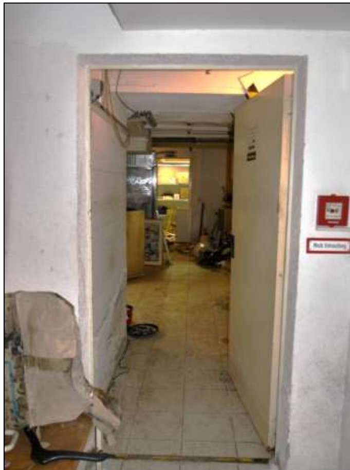
Zugang aus dem Kellerflur in die zentrale Kellerrdiele
