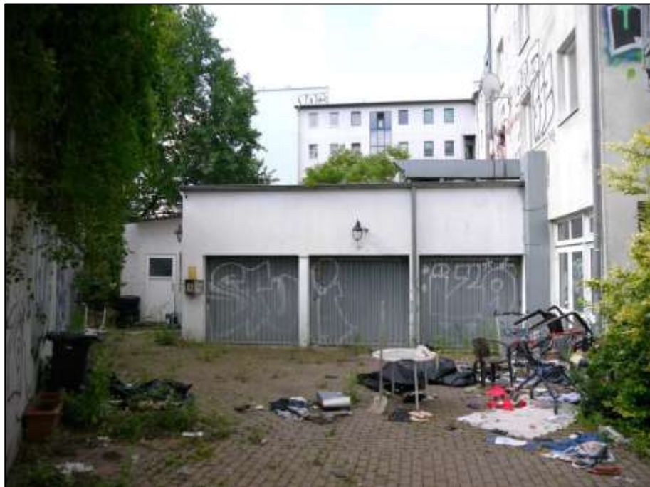
an das Gebäude im Bereich des Erdgeschosses rückwärtige anbindender Garagen-Anbau mit Parkliffersystem nebst Schiebebühne für 8 PKW und Holzschuppen-Anbau vor der zum Bahndamm aufgehenden Stützwand links im Bild
