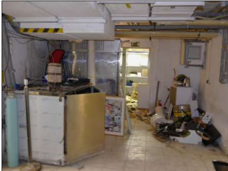
zentrale Kellerrdiele mit Blick in Richtung des der linken Brandwand sowie Lüftungskanälen unter der Raumdecke und Fassbier-Kühlzelle links im Bild
