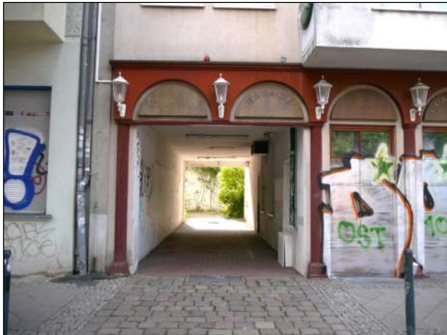
straßenseitige Front der auf dem Grundstück Gürtelstr. 41 aufstehenden Übernachtungsherberge als Hotel garni im Bereich der Erdgeschosszone mit unterkellierter Gebäudedurchfahrt mit hieraus vorhandenen Nebeneingängen zur Küche und zur Lounge
