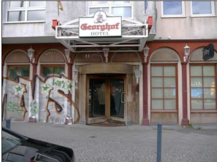
straßenseitige Front der auf dem Grundstück Gürtelstr. 41 aufstehenden Übernachtungsherberge als Hotel garni im Bereich der Erdgeschosszone mit zentraler Karusselltür als Hoteleingang
