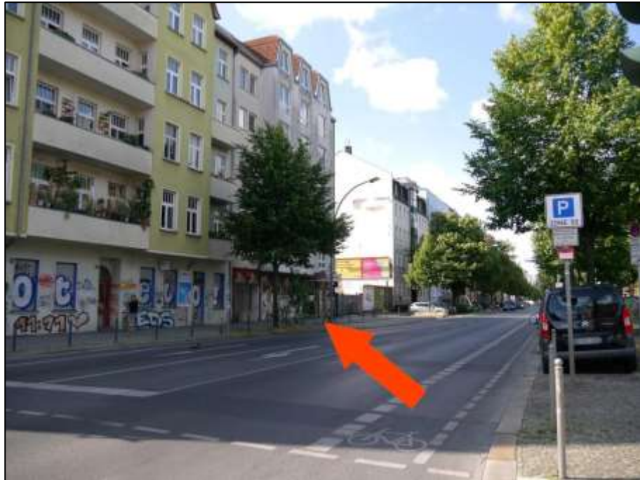
Blick über die Gürtelstraße nach Süden auf das Grundstück Gürtelstr. 41 auf der süd-östlichen Straßenseite mit aufstehender Übernachtungsherberge als Hotel garni (Pfeil)
