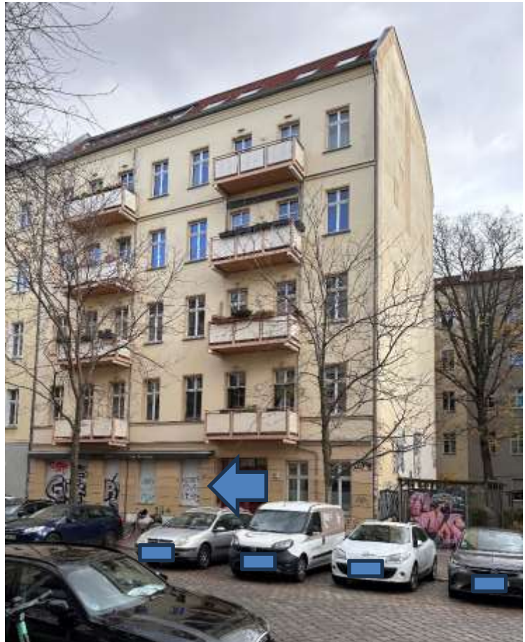
Straßen- und Giebelfassade
