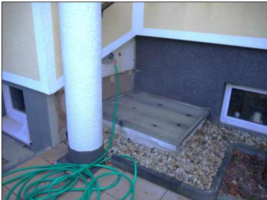
abgedeckter Schacht im Zwickel zwischen Giebelseite des Gebäudestamms und unterkellertem Auslucht-Anbau mit Abwasserhebeanlage
