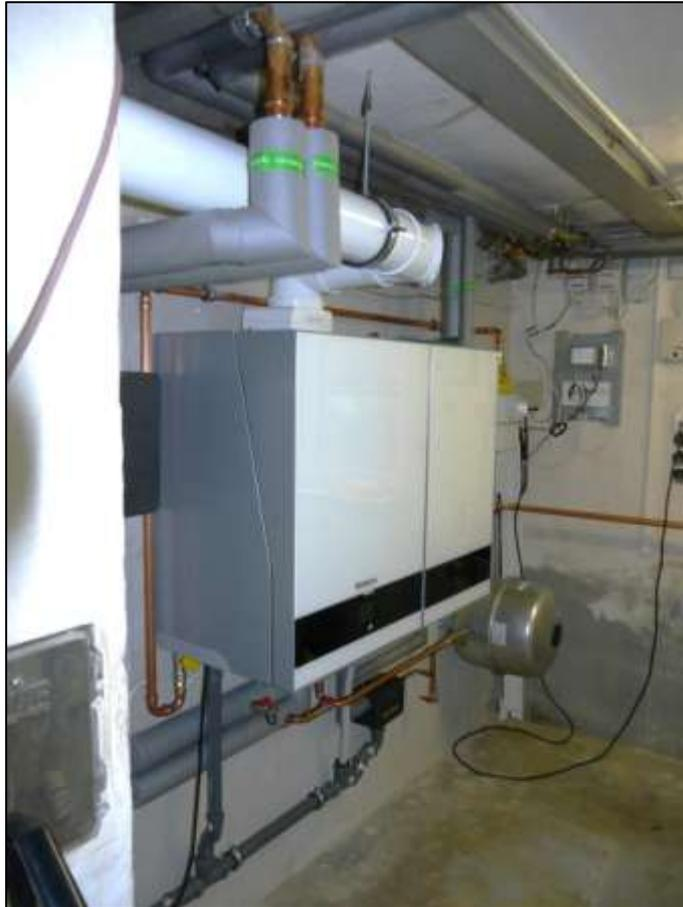
Heizzentrale im Kellergeschoss mit Brennwerttherme und Warmwasserspeicher sowie Gas-Anschluss und Schwachstromanlage etc.
