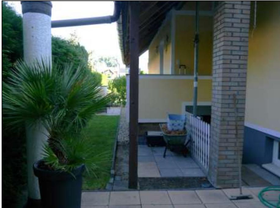
Blick in den rechten Bauwich vor der Hauseingangsfront mit Kelleraußentreppe rechts im Bild und dahinter anbindender Auskoffierung der aufgehenden Hauseingangstreppe - im Vordergrund Sichtmauerwerkspfeiler als Vordachstütze und zusätzliche Vollholzstütze links davon
