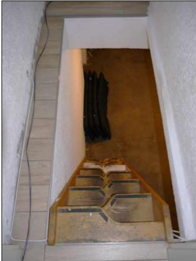
im Treppenloch der Kellerdecke neu eingebaute Raumspartrappe als Zugang aus der Hochparterrewohnung in das Kellergeschoss
