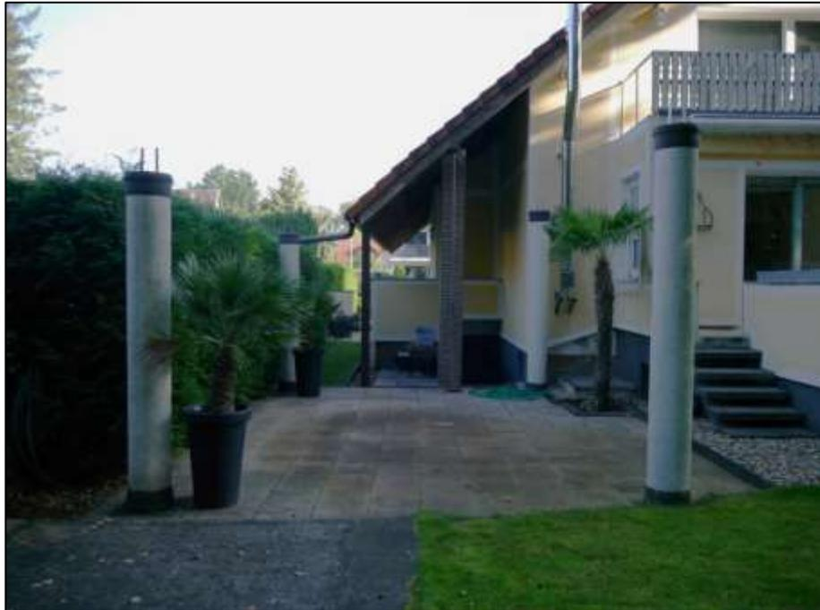
befestigte ebenerdige Freisitzfläche mit projektierte Überdachung und diesbzgl. bereits errichteten Betonsäulen mit Anfängereisen am Kapitell - Blick aus dem rückwärtigen Garten in den rechten Bauwuch vor der Hauseingangsfront
