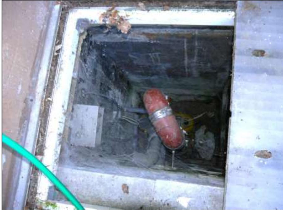
offener Schacht im Zwickel zwischen Giebelseite des Gebäudestamms und unterkellertem Auslucht-Anbau mit Abwasserhebeanlage
