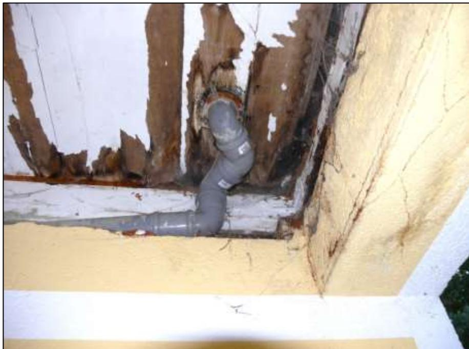
maroder Zustand der Decke über dem Erdgeschoss im Bereich der Balkonterrasse über dem Ständerker-Anbau (Auslucht-Anbau) im Bereich der Raumnische vor der gartenseitigen Giebelseite des Gebäudestamms
