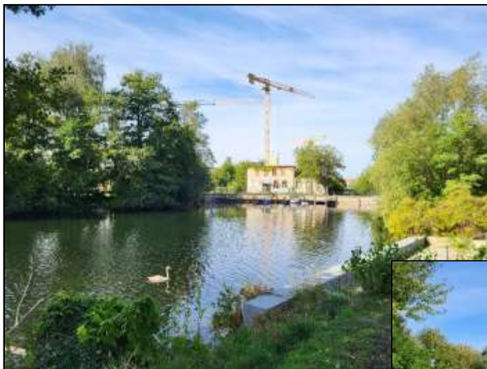
Bild 7: Sicht von Südost über die zugehörige Wasserfläche auf das zugehörige Denkmalgebäude
