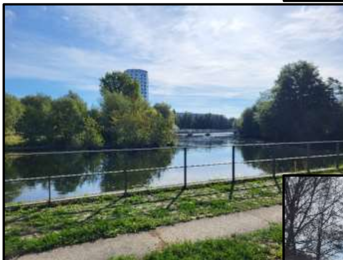
Bild 3: Sicht nach Südost über den öffent- lichen Kai auf die zugehörige Wasserflä- che und die Fußgänger-Klappbrücke
