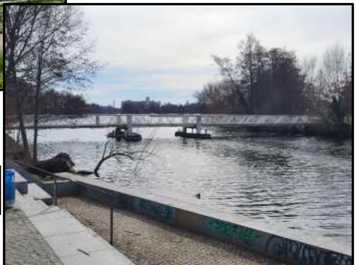
Bild 3: Sicht vom östlichen Ufer auf Fuß- gänger-Klappbrücke
