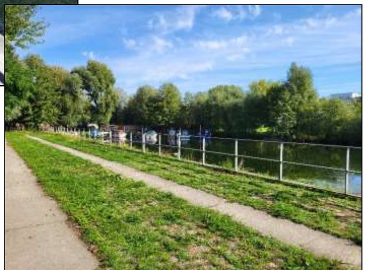
Bild 8: Sicht von Südwest über den Kai und die zugehörige Wasserfläche auf die Stege der nördlichen Anrainer
