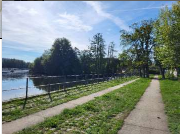
Bild 6: Sicht nach Süden über den öffentlichen Kai auf die zugehörige Wasserfläche und die Fußgänger-Klappbrücke
