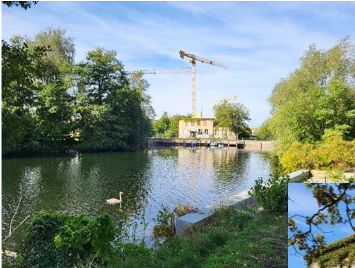
Bild 1: Am Maselakepark 44 – Ansicht auf Denkmalgebäude
