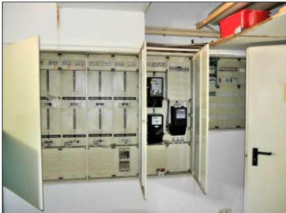
Elektro-Zählerschränke im Hausanschlussraum (Elektro und Gas) im Kellergeschoss des Vorderhauses
