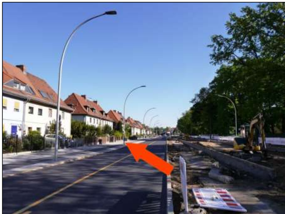
Blick in die Oranienburger Straße nach Norden mit Lage des Grundstücks Oranienburger Str. 270 nebst aufstehendem Einfamilienreihenmittelhaus auf der westlichen bzw. im Bild linken Straßenseite (Pfeil)
