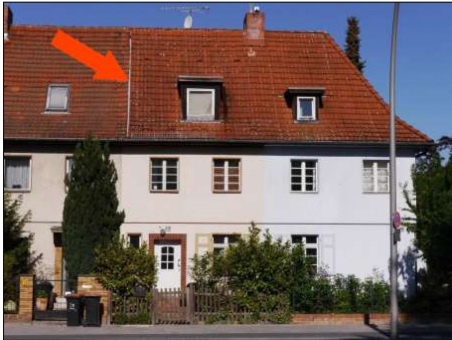
straßenseitige Front des Grundstücks Oranienburger Str. 270 mit aufstehendem Einfamilienreihenmittelhaus (Pfeil)
