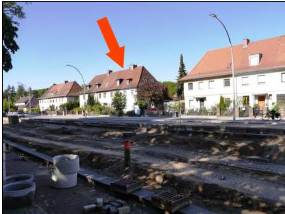
Blick über die Oranienburger Straße nach Süd-Westen mit Lage des Grundstücks Oranienburger Str. 270 nebst aufstehendem Einfamilienreihenmittelhaus (Pfeil)
