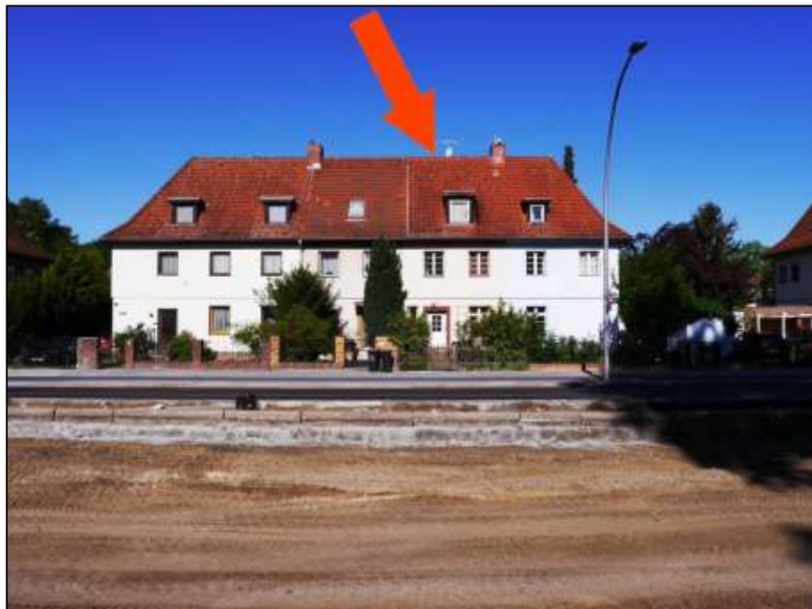
Blick über die Oranienburger Straße nach Westen mit Lage des Grundstücks Oranienburger Str. 270 nebst aufstehendem Einfamilienreihenmittelhaus (Pfeil)
