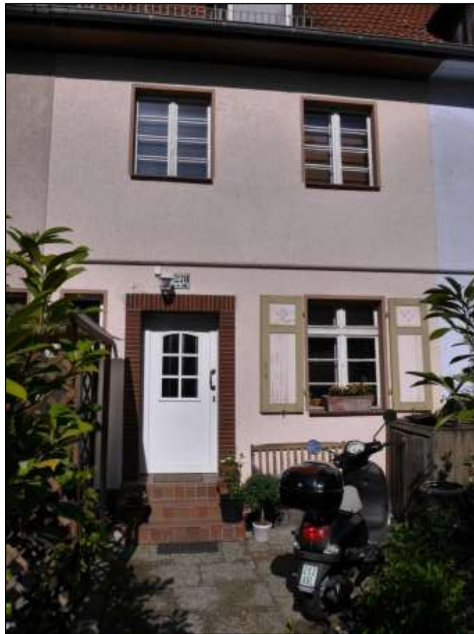
straßenseitige Front des auf dem Grundstück Oranienburger Str. 270 aufstehenden Einfamilienreihenmittelhause
