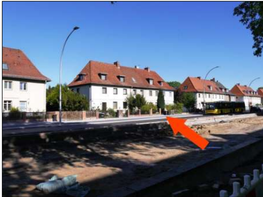
Blick über die Oranienburger Straße nach Nord-Westen mit Lage des Grundstücks Oranienburger Str. 270 nebst aufstehendem Einfamilienreihenmittelhaus auf der westlichen bzw. im Bild linken Straßenseite (Pfeil)
