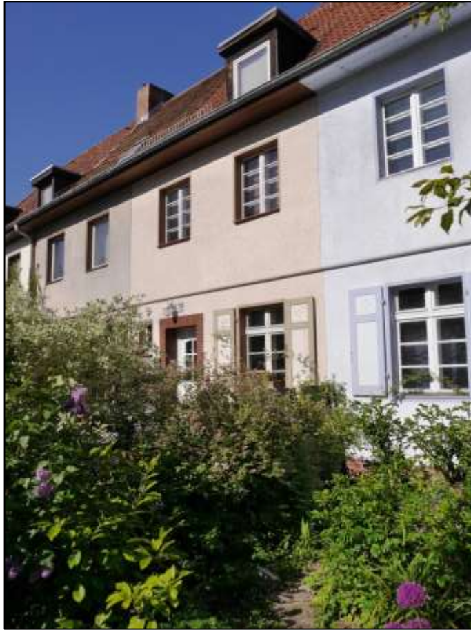
straßenseitige Front des Grundstücks Oranienburger Str. 270 mit aufstehendem Einfamilienrei- henmittelhaus
