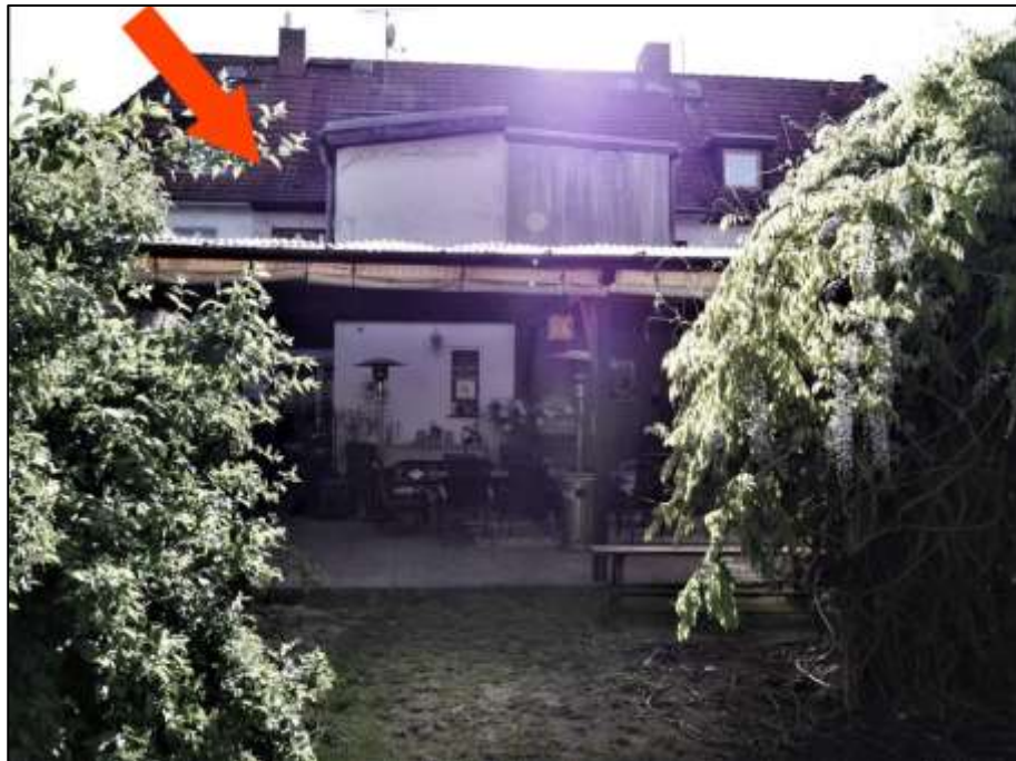
Blick nach Osten aus dem rückwärtigen Garten auf das auf dem Grundstück aufstehende Einfamilienreihenmittelhaus mit Gebäude-stamm (Pfeil) und anbindendem Seitenflügel mit entsprechendem Seitenflügel auf dem südlichen Nachbargrundstück (rechts im Bild)
