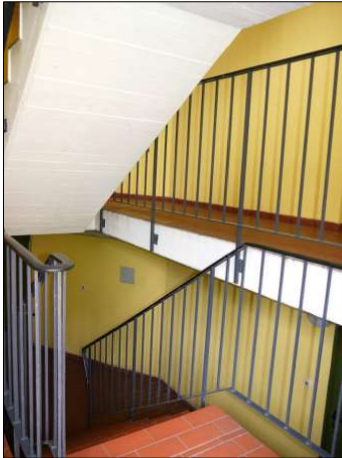
offener Keller- treppenabgang im Treppen- haus
