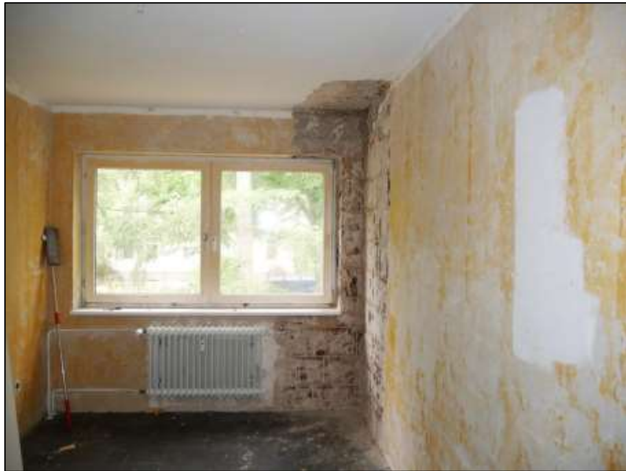
Durchnässungsbereich in einer Wohnung aufgrund von eindringendem Niederschlagswasser aus dem Aufstockungsbereich auf dem Flachdach oberhalb des 1. Obergeschosses des ursprünglichen Gebäudebestandes
