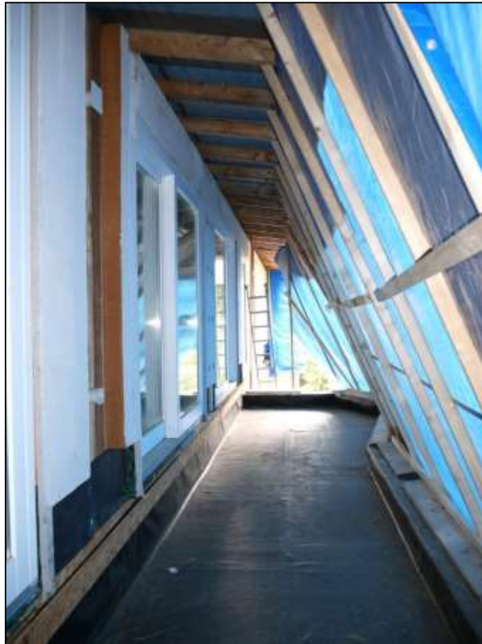
süd-westliche Gebäudefront der als 2.OG auf dem ur- sprünglichen Flachdach er- richteten Ge- schossaufsto- ckung
