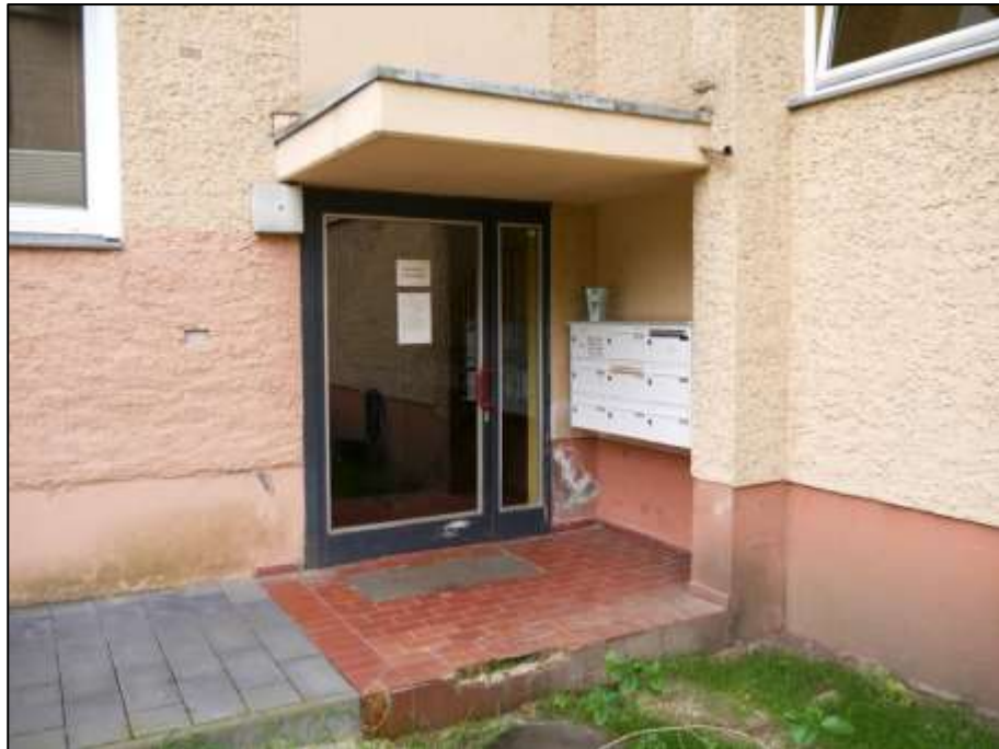
Hauseingangstür zum Treppenhaus in der nord-westlichen Gebäudefront mit davor belegener mit Spaltplattenkeramik abgesetzter gedeckter Podestfläche
