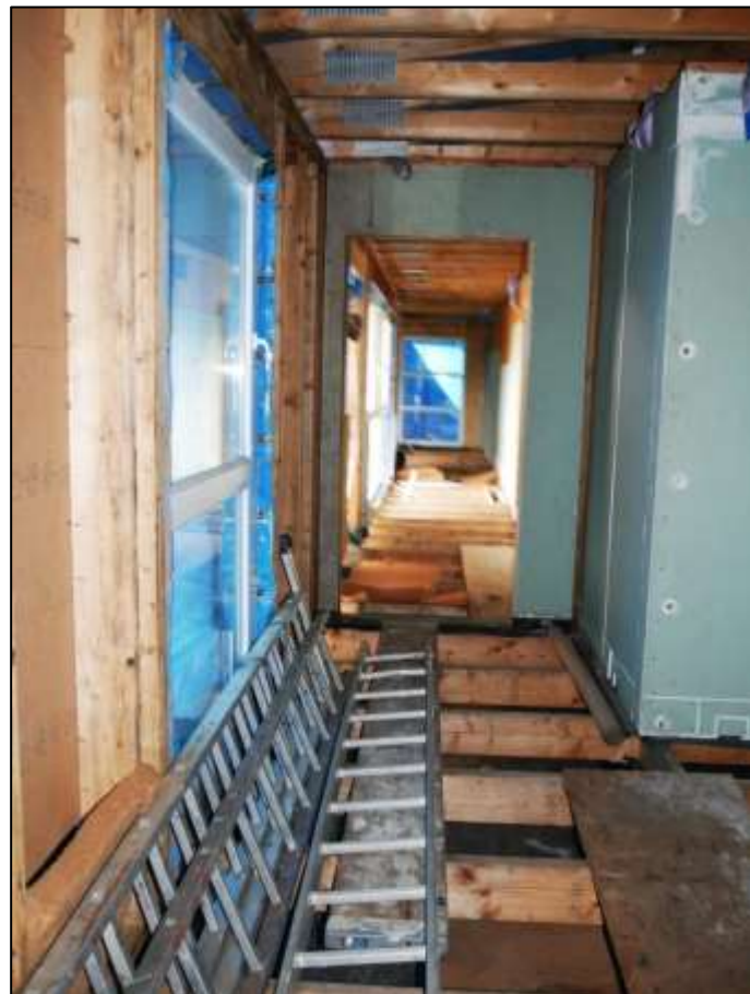
Blick aus dem Dielenbereich vor der nordöstlichen Außenfront der vorgesehenen ETW-Nr. 11 in der Geschossaufstockung in Richtung des vorgesehenen Treppenhauses mit rückwärtigem Fenster in der südöstlichen Giebelseite im Hintergrund und links im Bild belegenes Fenster in der nordöstlichen Gebäudefront
