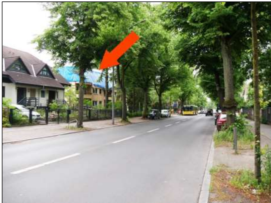
Blick in die Berliner Straße (B96) nach Süd-Osten mit Lage des auf dem Eckgrundstücks Schildower Str. 1 aufstehenden Wohngebäudes auf der nord-östlichen bzw. im Bild linken Straßenseite (Pfeil)
