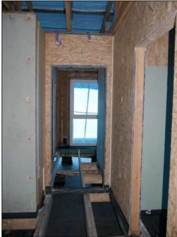
Durchgang bzw. Bereich des vorgesehe- nen Flurs zur vorgesehenen Diele vor der nord-östlichen Gebäudefront der vorgesehe- nen ETW-Nr. 11
