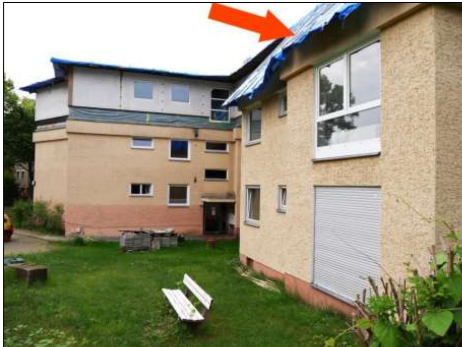
nord-westliche Hauseingangsfront des auf dem Grundstück aufstehenden Gebäudes mit Geschossaufstockung als 2.OG - rechts im Bild nord-östliche Front des rückwärtigen Gebäudeteils mit anbindender nord-westlicher Giebelseite und Lage der ETW-Nr. 11 im Aufstockungsbereich (Pfeil)
