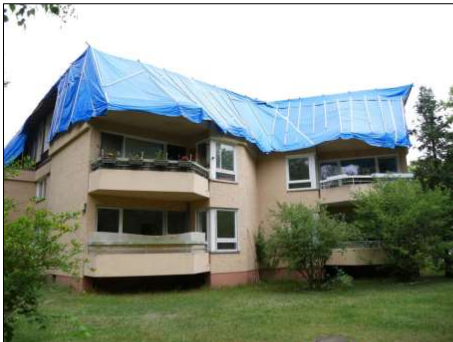
südliche Front des auf dem Grundstück aufstehenden Gebäudes mit Geschossaufstockung als 2.OG
