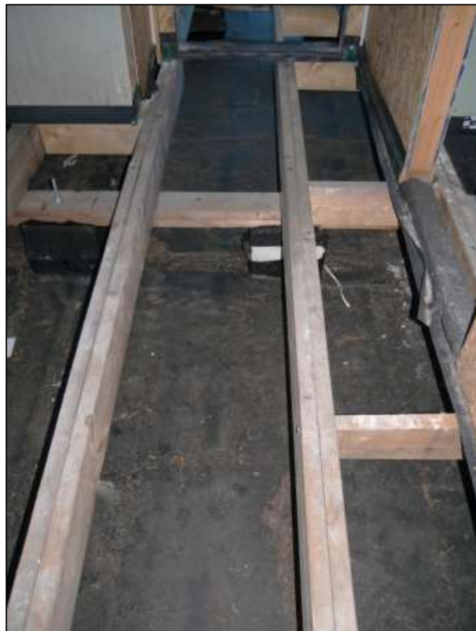
aufgesattelte Trägerkonstruk- tion der Aufsto- ckungsmaß- nahme auf dem Flachdach des ursprünglichen Gebäudebe- standes mit Verschraubung in der Betonde- cke
