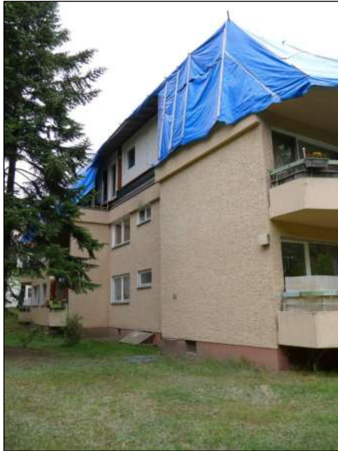
zur Berliner Straße (B96) nach Süd-Westen orientierte Gebäudefront des auf dem Grundstück Schildower Str. 1 aufstehenden Wohngebäudes mit darauf errichteter Geschossaufstockung als 2. Obergeschoss mit Lage der ETW-Nr. 11 im Bereich der Aufstockung im Hintergrund links
