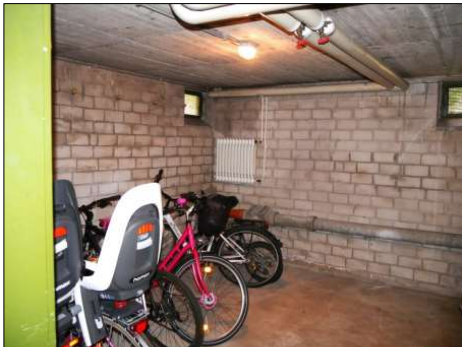
derzeit als Fahrradkeller genutzter Raum mit darin vorgesehenem Einbau der Abstellkeller Nrn. 9, 10 und 11 der im Aufstockungsbereich herzustellenden Wohnungen
