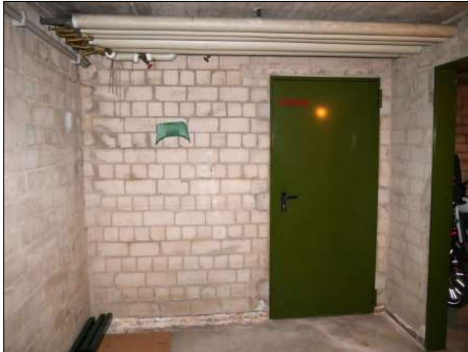
Vorkeller mit anbindendem Hauanschlussraum (Strom) und rechts im Bild anbindenden Raum mit Nutzung derzeit als Fahrradkeller und darin vorgesehenem Einbau der Abstellkeller Nrn. 9, 10 und 11 der im Aufstockungsbereich herzustellenden Wohnungen
