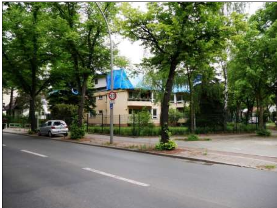
Blick über die Berliner Straße (B96) nach Norden mit Lage des Eckgrundstücks Schildower Str. 1 auf der nord-östlichen Seite der Berliner Straße
