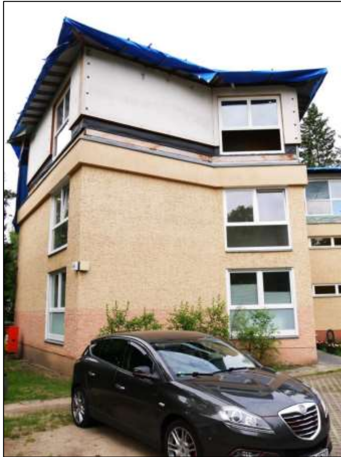
östliche Front links und nord-östliche Front des auf dem Grundstück aufste- henden Gebäudes mit Geschossauf- stockung als 2.OG
