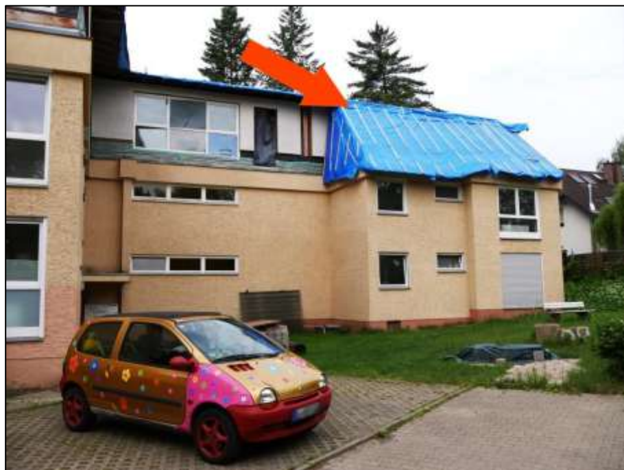
nach Nord-Osten orientierte Front des auf dem Grundstück aufstehenden Gebäudes mit Geschossaufstockung als 2.OG und Lage der ETW-Nr. 11
