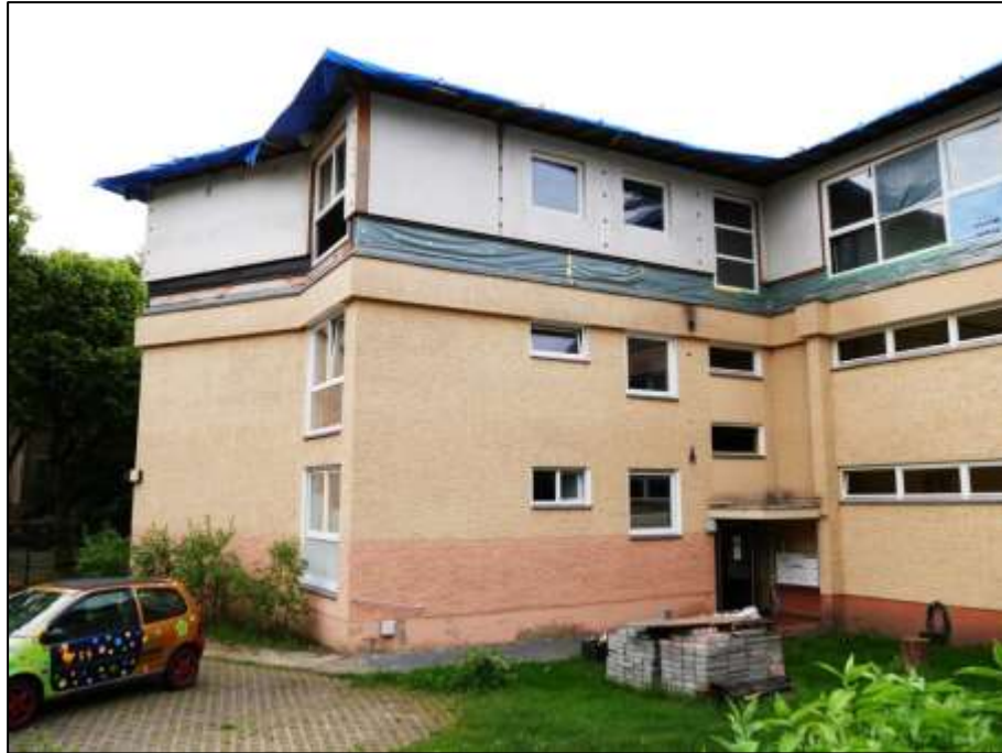
Nord-östliche Front links und nord-westliche Hauseingangsfront des auf dem Grundstück aufstehenden Gebäudes mit Geschossaufstockung als 2.OG
