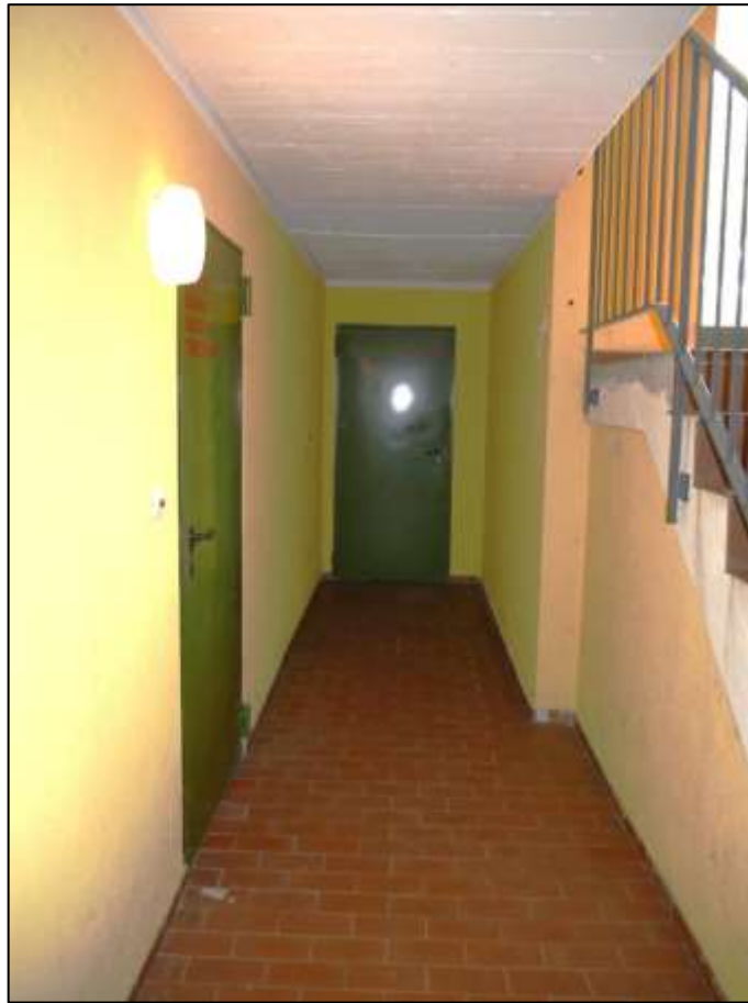
vorderer Teil des Kellerflurs
