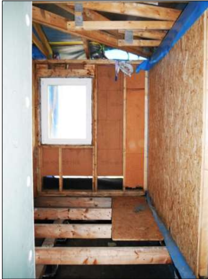
Badezimmer der vorgesehenen ETW-Nr. 11 in der Geschossaufstockung mit Fenster in der nordwestlichen Giebelseite des Gebäudes
