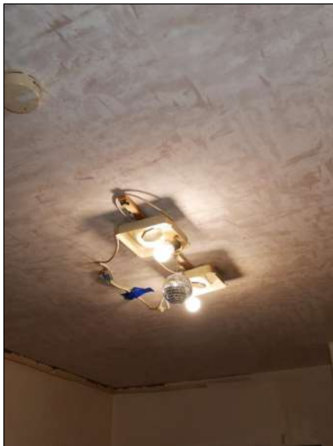
Durchnässungsbereich in einer Wohnung aufgrund von eindringendem Niederschlagswasser aus dem Aufstockungsbereich auf dem Flachdach oberhalb des 1. Obergeschosses des ursprünglichen Gebäudebestandes
