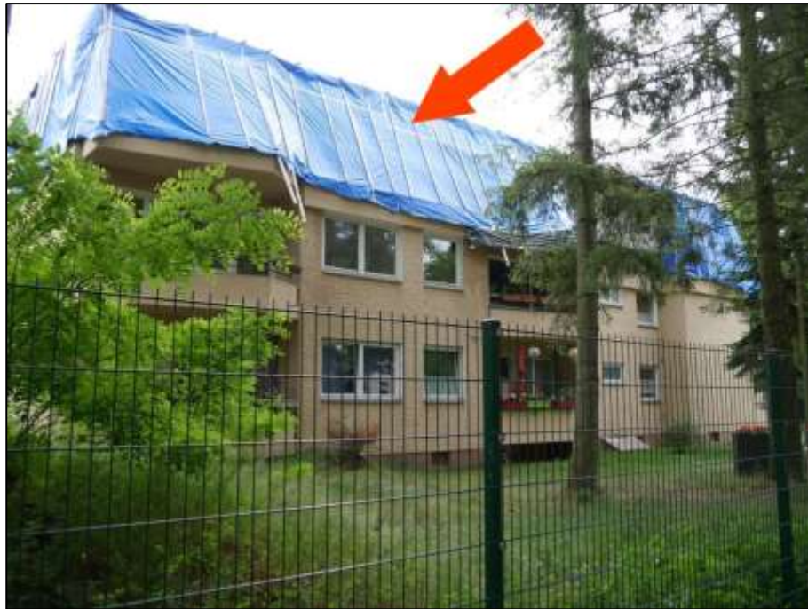
Blick aus der Berliner Straße (B96) nach Osten mit Lage des auf dem Grundstück Schildower Str. 1 aufstehenden Wohngebäudes und darauf errichteter Geschossaufstockung als 2. Obergeschoss mit Lage der ETW-Nr. 11 im Bereich der Aufstockung (Pfeil)
