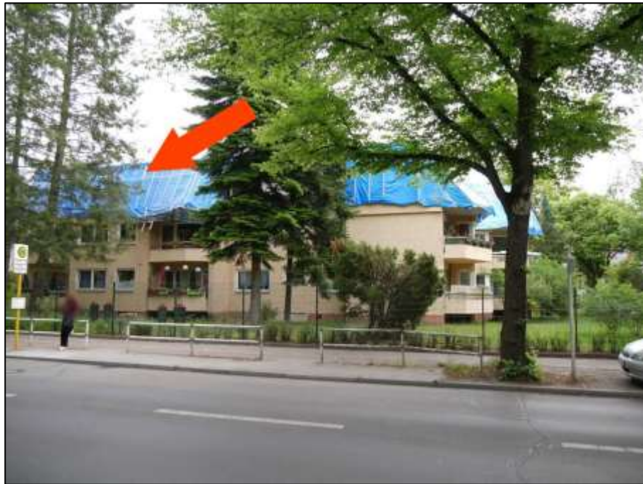
Blick über die Berliner Straße (B96) nach Nord-Osten mit Lage des auf dem Grundstück Schildower Str. 1 aufstehenden Wohngebäudes und darauf errichteter Geschossaufstockung als 2. Obergeschoss mit Lage der ETW-Nr. 11 im Bereich der Aufstockung (Pfeil)
