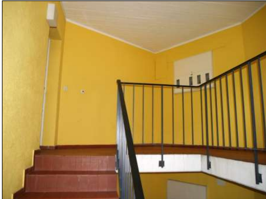
Treppenhauskopf im 1. Obergeschoss (noch ursprünglicher Bestand ohne Weiterführung der Treppe in den Aufstockungsbereich als 2. Obergeschoss)
