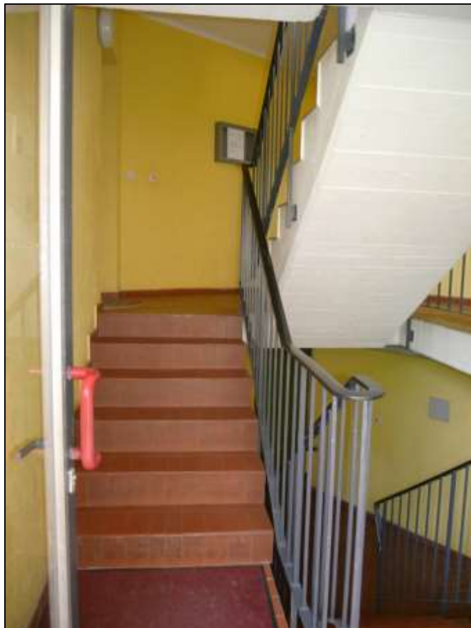
Hauseingangsbereich mit aufgehender Treppe und offenem Kellertreppengang rechts im Bild
