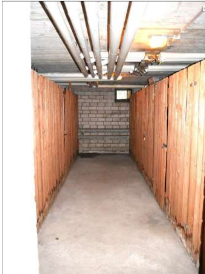
Holzplattenabstellverschlge der im ursprnglichen Gebudebestand vorhandenen Wohnungen im Kellergeschoss
