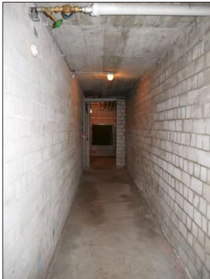
hinterer Teil des Kellerflurs
