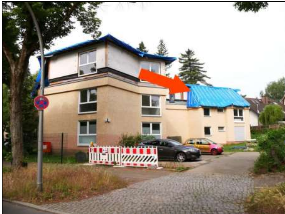
Blick aus der Schildower Straße nach Nord-Westen auf die Grundstückszuwegung und -auffahrt des Grundstücks Schildower Str. 1 mit auf dem Grundstück aufstehendem Wohngebäude und darauf errichteter Geschossaufstockung als 2. Obergeschoss mit Lage der ETW-Nr. 11
