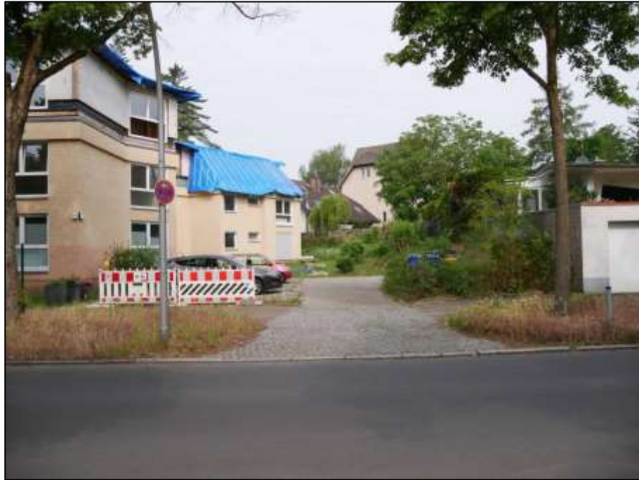
Blick über die Schildower Straße nach Nord-Westen auf die Grundstückszuwegung und -auffahrt des Grundstücks Schildower Str. 1 mit auf dem Grundstück aufstehendem Wohngebäude und darauf errichteter Geschossaufstockung als 2. Obergeschoss links im Bild
