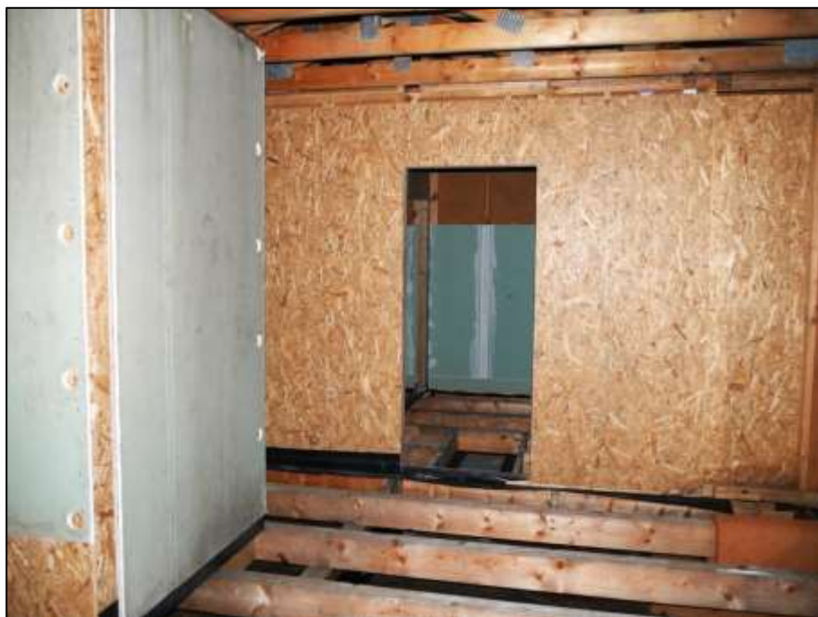
hinter der süd-westl. Gebäudefront der als 2.OG errichteten Geschossauf- stockung belegenes Wohnzimmer der vorgesehenen ETW-Nr. 11
