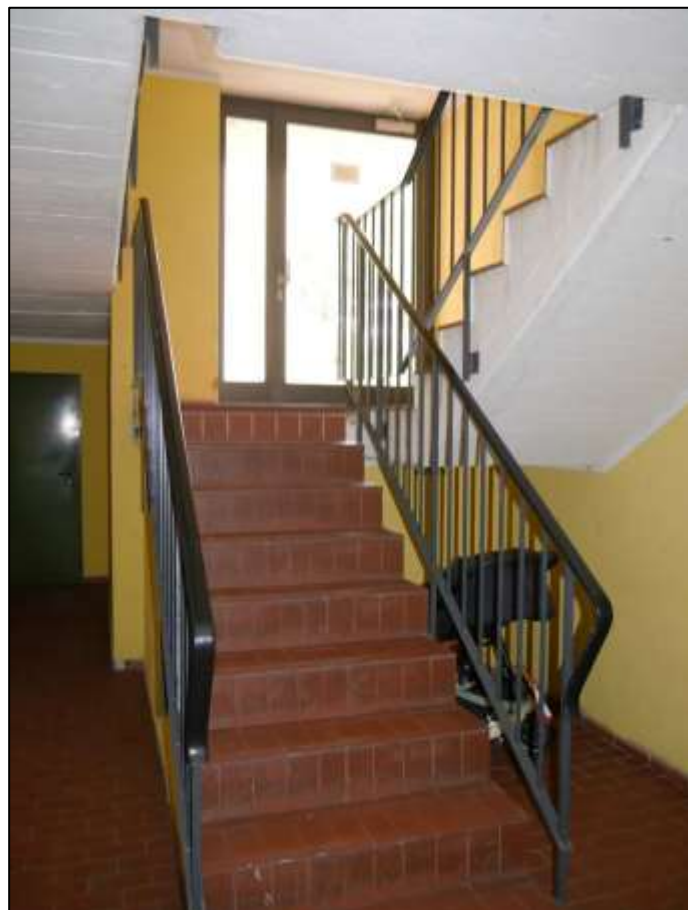
offener Keller- treppenabgang im Treppen- haus
