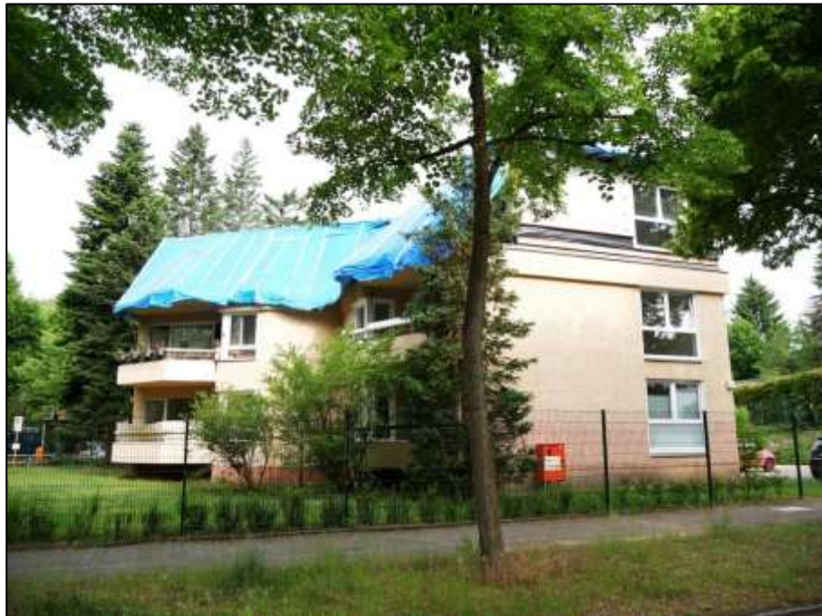
Blick aus der Schildower Straße nach Nord-Osten auf das auf dem Grundstück Schildower Str. 1 aufstehenden Wohngebäudes mit darauf errichteter Geschossaufstockung als 2. Obergeschoss
