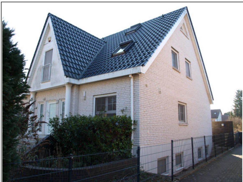
Abbildung 10: seitliche Ansicht aus Richtung Norden in Höhe des Wegerechts
