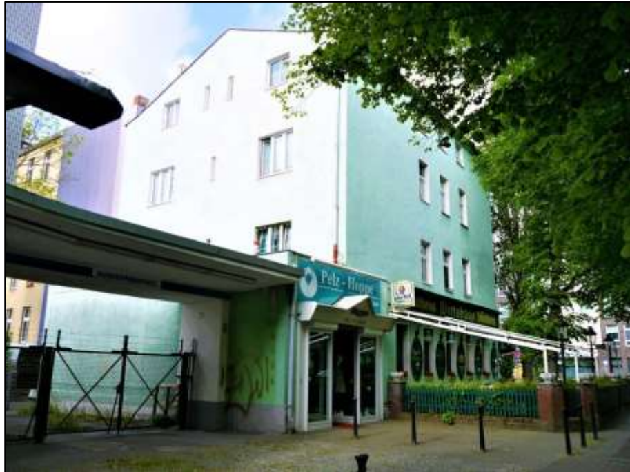
Blick aus der Anrainerstraße der Straße Alt-Tempelhof nach Süd-Westen auf die östliche Giebelseite sowie die nach Norden zur Straße Alt-Tempelhof orientierte Front des Gebäudes Alt-Tempelhof 61, Manteuffelstraße 69 auf dem Eckgrundstück Alt-Tempelhof 61, Manteuffelstr. 68, 69
