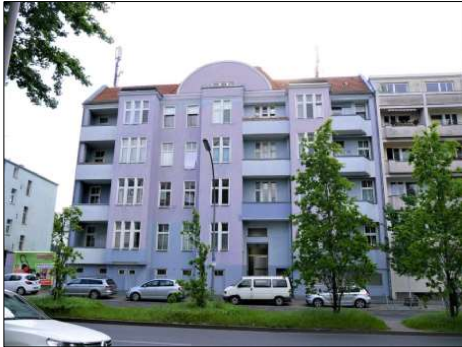
straßenseitige Front des Gebäudes Manteuffelstr. 68 auf der östlichen Straßenseite
