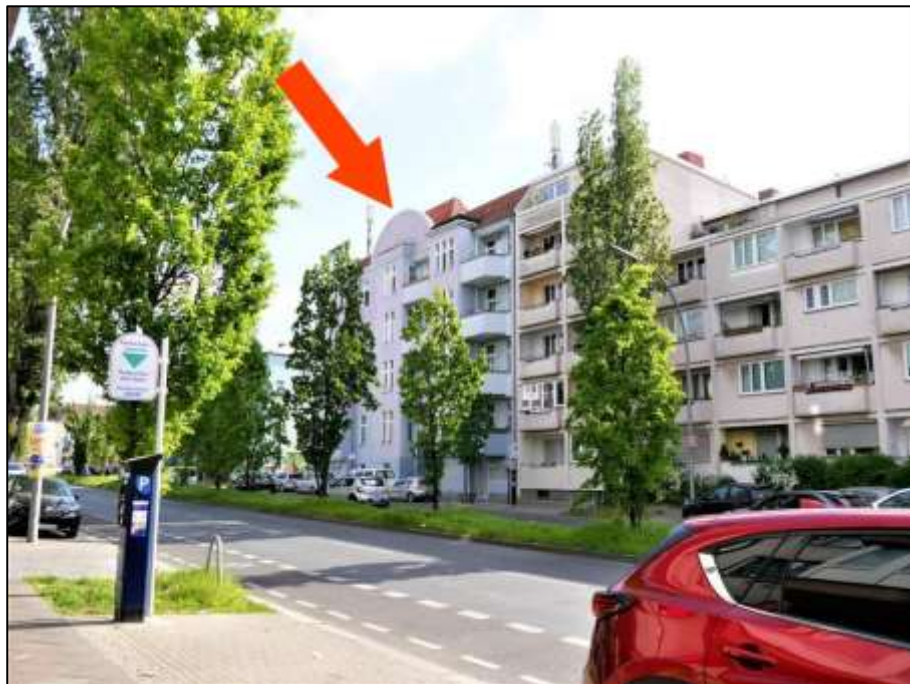
Gebäude Manteuffelstr. 68 auf der östlichen bzw. im Bild rechten Seite der Manteuffelstraße (Pfeil)
