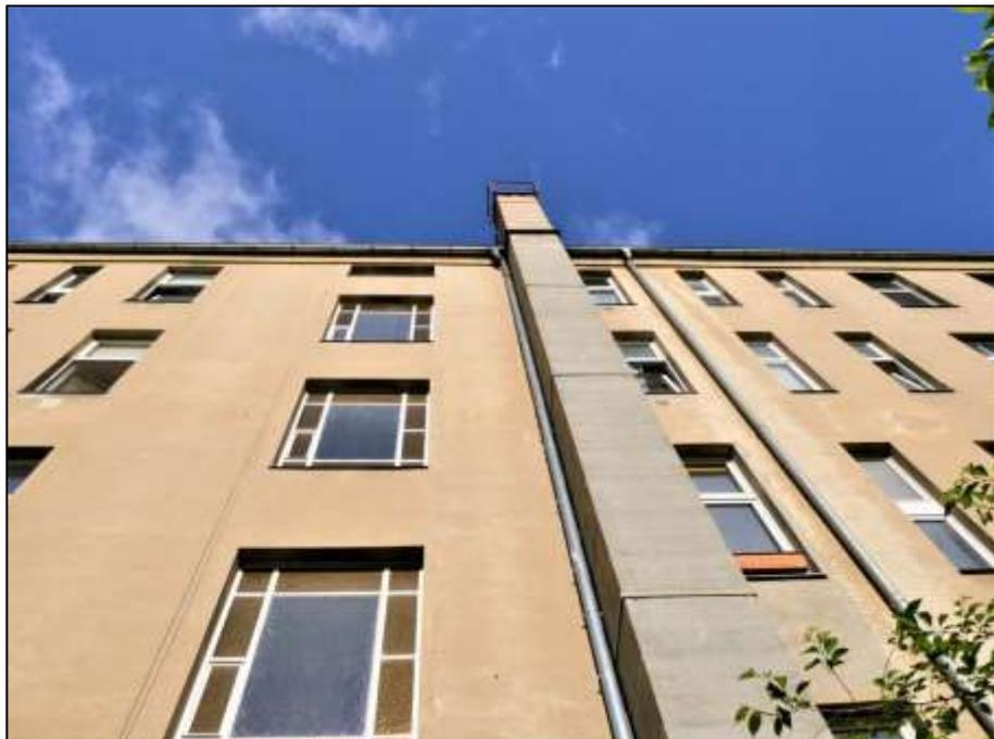
rückwärtige bzw. östlichen Fassade des Gebäudes Manteuffelstr. 68 im Bereich der Obergeschosse mit sogen. Fassaden-Schornstein
