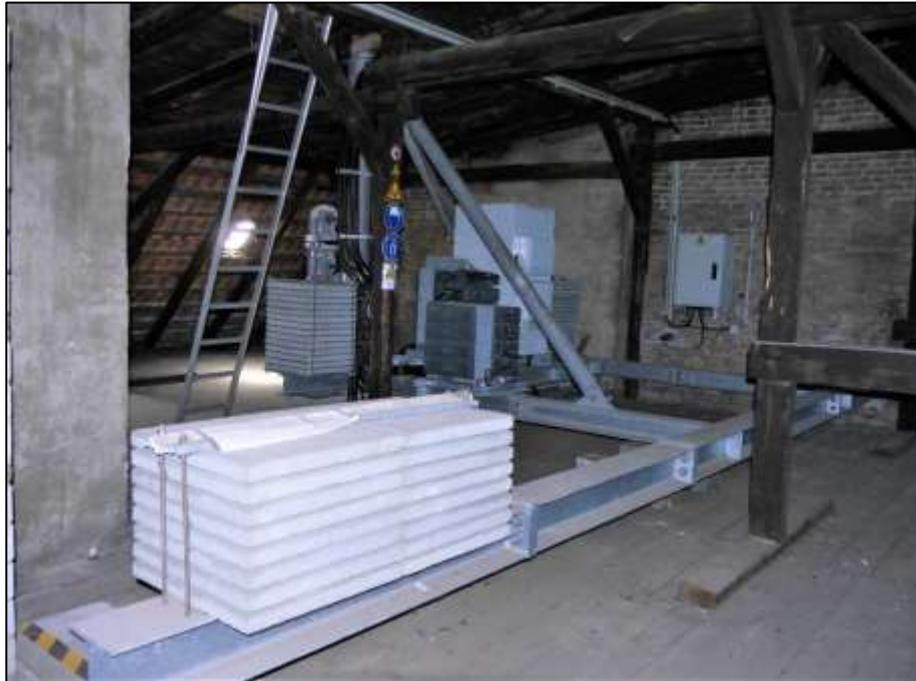
Rohdachboden im Gebäude Manteuffelstr. 68 mit Equipment einer über Dach aufgehenden Mobilfunk-Antennenanlage
