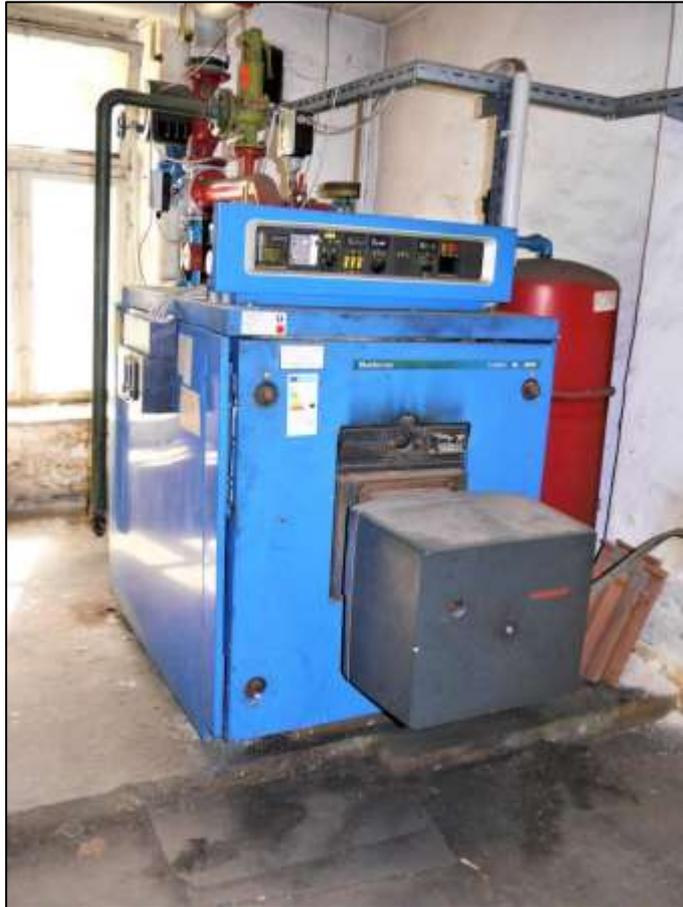
Heizungskeller in dem weitgehend über Terrain belegenen Untergeschoss als nominelles Kellergeschoss im Gebäude Manteuffelstr. 68 mit veraltetem Öl-Heizkessel
