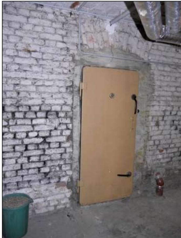
Flur in dem weitgehend über Terrain belegenen Untergeschoss als nominelles Kellergeschoss im Gebäude Manteuffelstr. 68 mit Zugang eines Kellerraums über eine alte Luftschutztür
