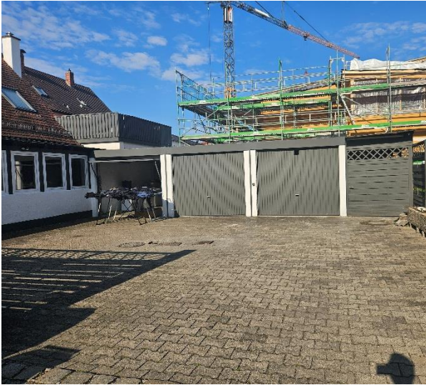
Außenansicht Garagen + Fahrrad/Mülltonnenabstellfläche (rechts im Bild)
