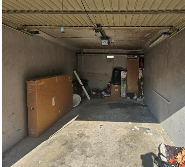
Innenansicht Garage – exemplarisch -
