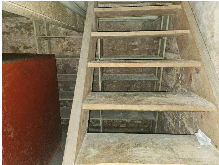
Treppenabgang in den Keller
