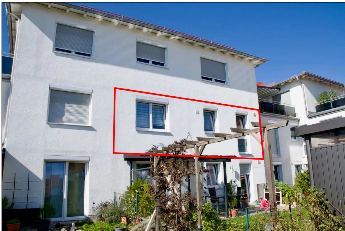
Foto 2 Ansicht von Süd-Osten
