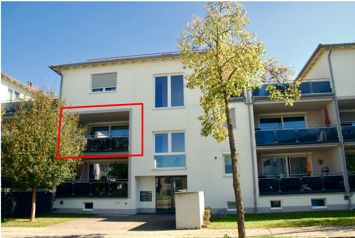
Foto 1 Eingangsansicht von Nord-Westen
