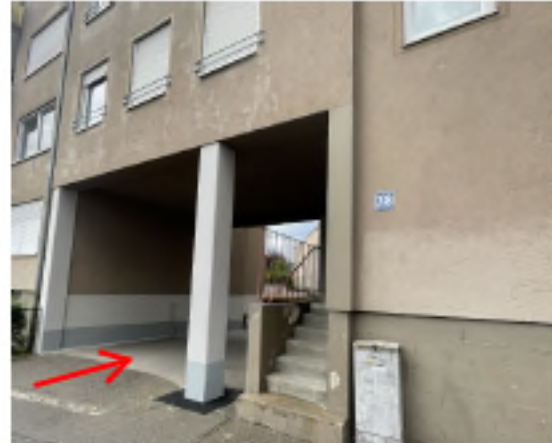
Durchfahrt durch Gebäudeteil Hsnr. 38 von der Brunnenstraße zum Garagenhof
