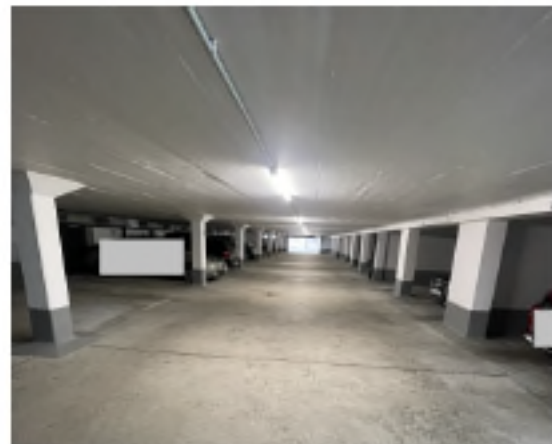
... TG- Innenraum, im Hintergrund Ein- /Ausfahrt
