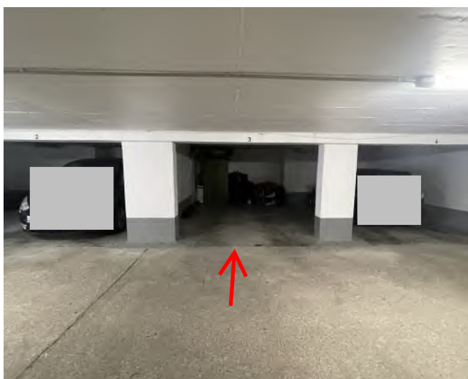
TG-Stellplatz zu A) lt. ATP Nr. 10, abweichend von Nummerierung im ATP am Gebäude mit Nr. 3 gekennzeichnet
