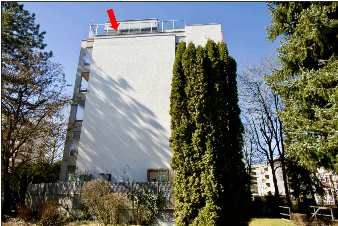
Foto 3 Ansicht von der Bergiusstraße
