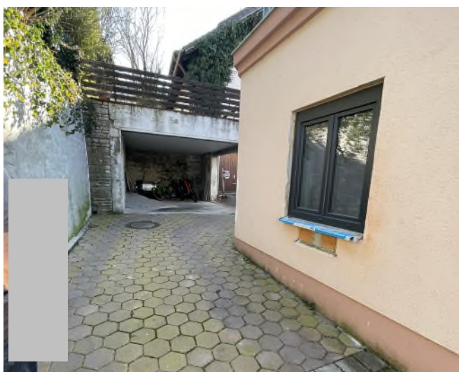
Befestigte Grundstückszufahrt entlang der Gebäude-Fassade O ...
