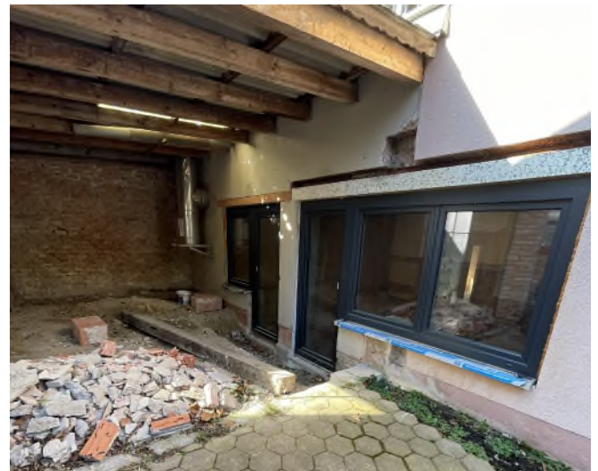
Eingehauster Terrassenbereich, SNR f. Bewertungsobjekt zu A) lt. ATP Nr.1
