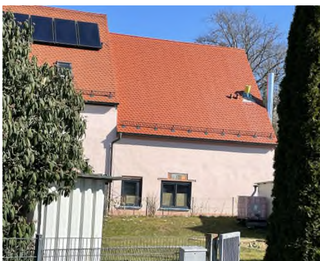
Westfassade Gebäudeteil Süd auf Flst 156
