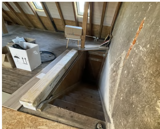
... Treppenabgang in das OG (TRH 1)
