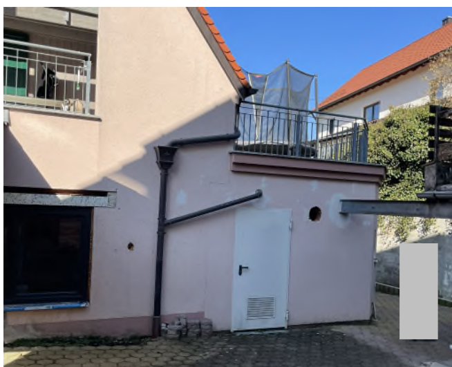
Rückwärtiger Grundstücksbereich ... Teil der Gebäude-Fassade S...
