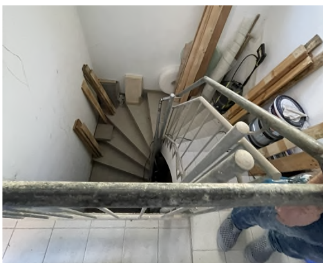
Treppenabgang EG-KG "TRH2"
