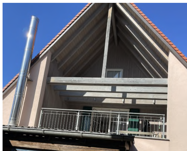
... Dachloggia Bewertungsobjekt zu C), Gebäude-Fassade S
