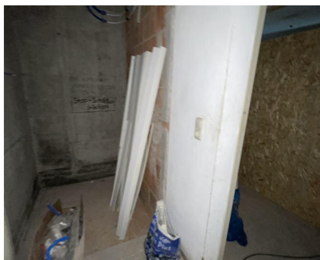
Beispiel baulicher Zustand KG, Gebäudeteil S
