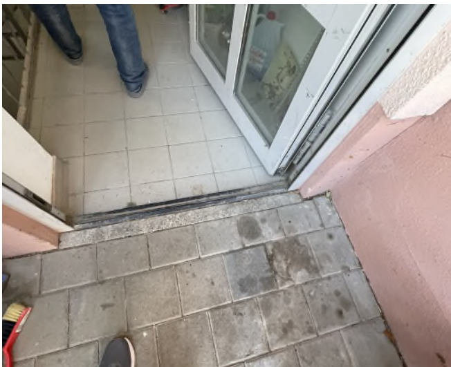
Hauseingang Gebäudeteil Süd, "TRH 2", Gebäudefassade N ...
