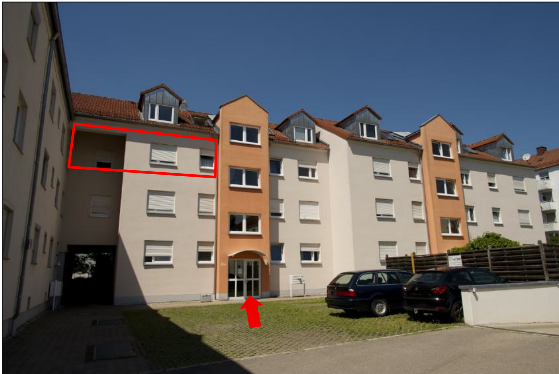
Foto 1 Soldnerstraße 24 a - Ansicht von Osten
