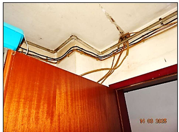
Wohnhaus A – Leitungen EG
