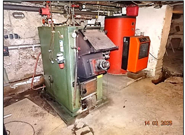
Wohnhaus A – Heizraum KG
