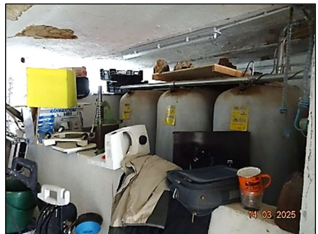
Nebengebäude B – innen
