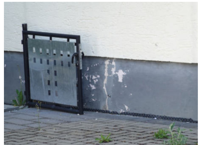
Schäden im Bereich des Außensockels
