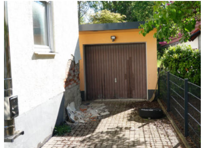
Schäden im Bereich des Außensockels
