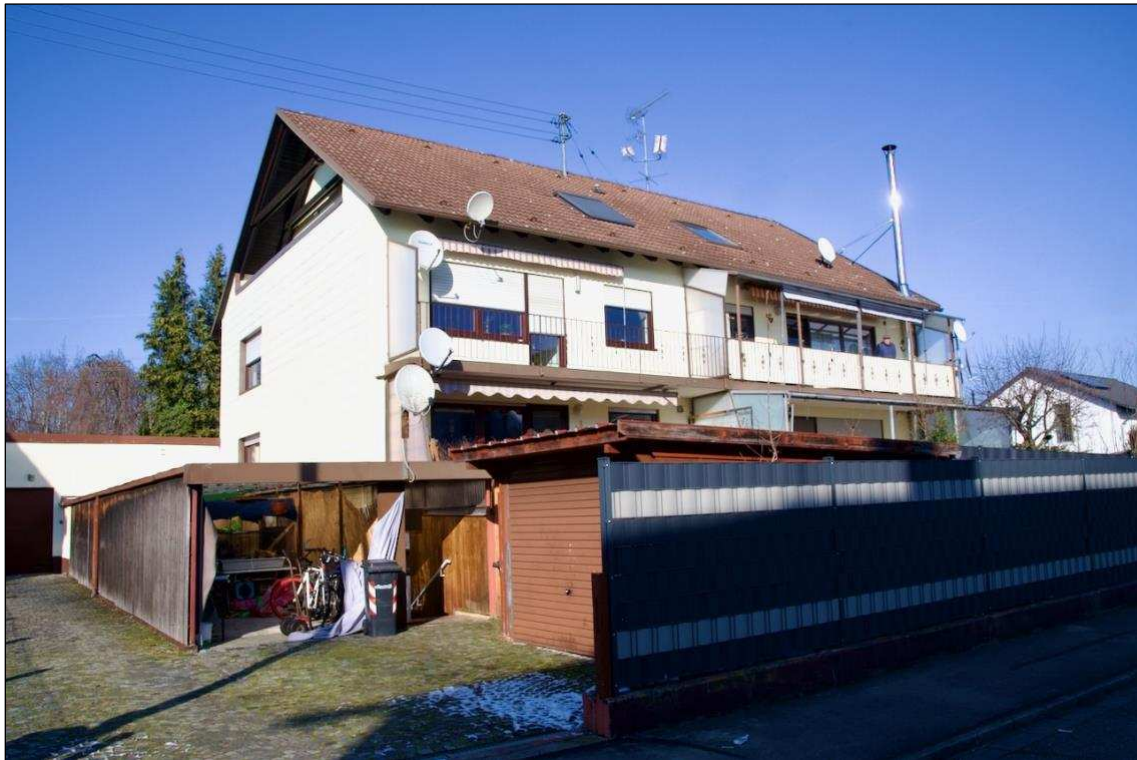
Foto 3 Ansicht von Süd-Westen
