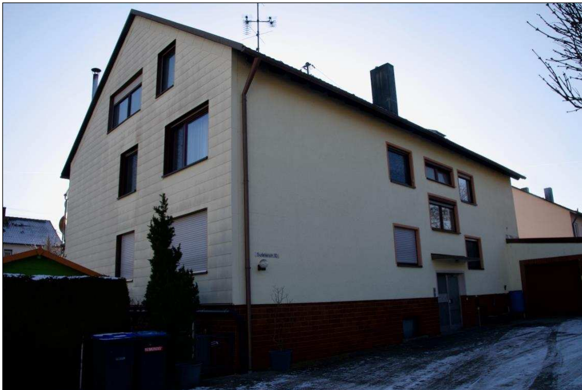
Foto 1 Eingangsansicht von Westen
