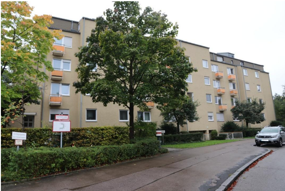
Außenansicht: Mehrfamilienhaus von Norden
