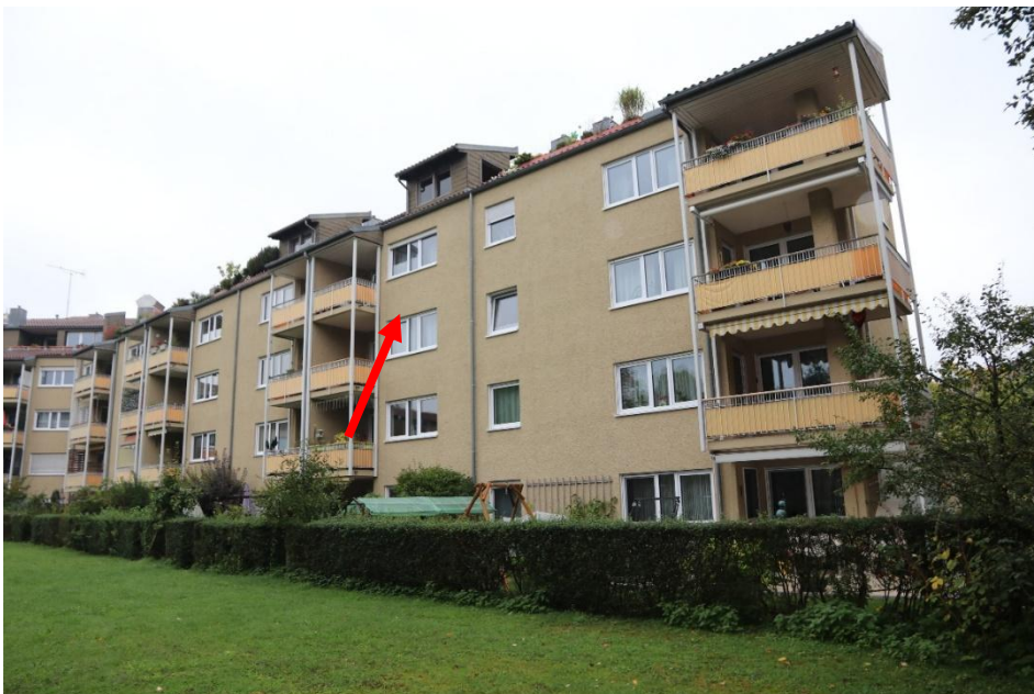
Außenansicht: Mehrfamilienhaus von Süden (roter Pfeil = Lage der zu bewertenden Wohnung)
