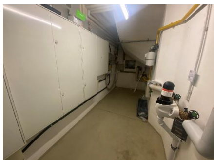
Hausanschlussraum (Gas, Wasser, Strom)
