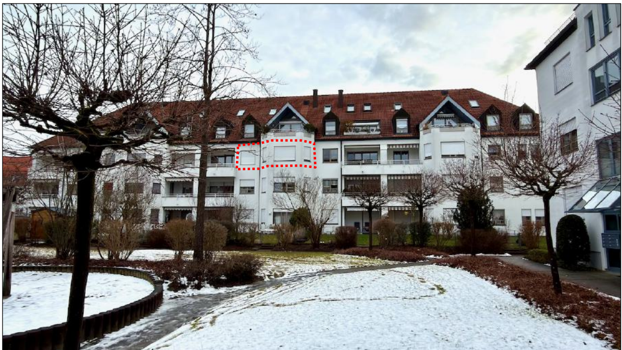
Foto 8 Ansicht von Westen
