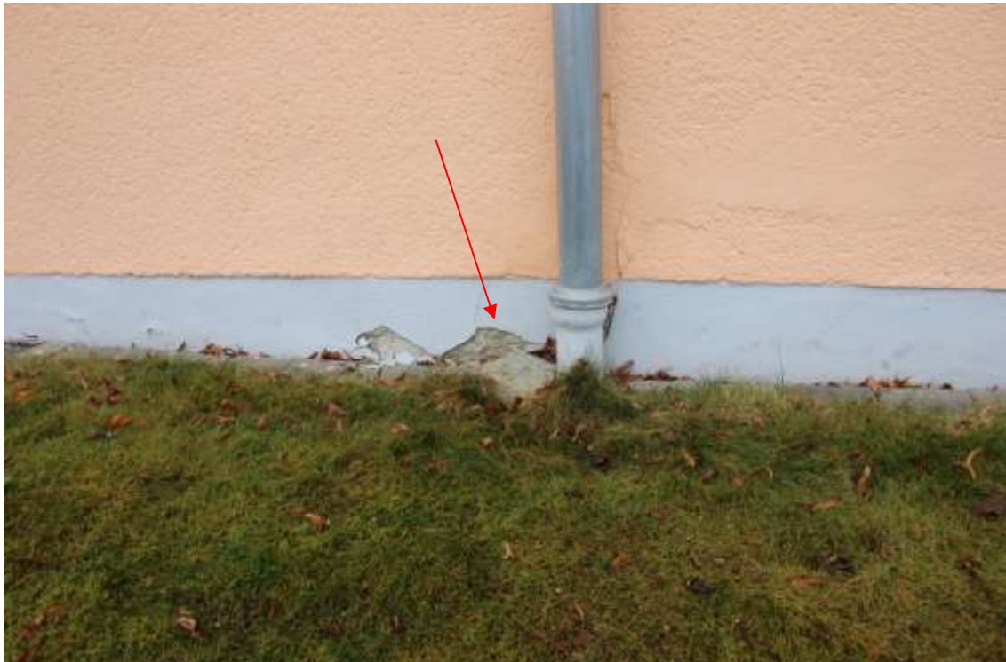
Detailansicht Nordfassade Haus 178/178a mit Putzabplatzungen
