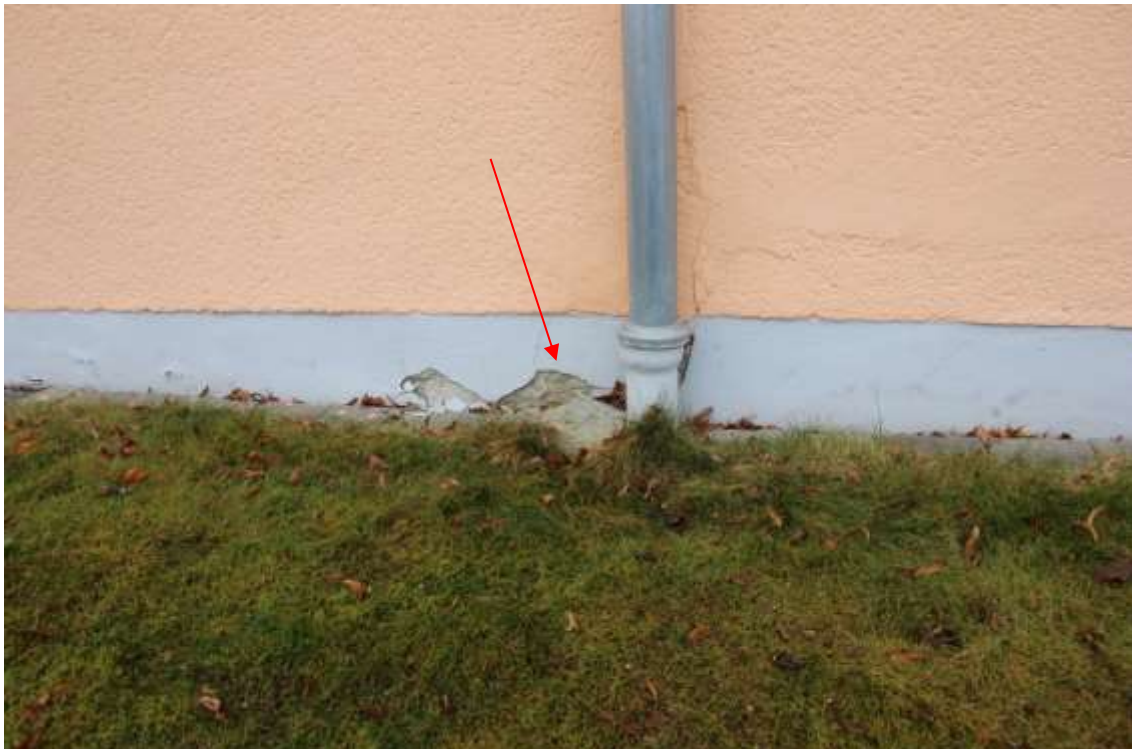
Detailansicht Nordfassade Haus 178/178a mit Putzabplatzungen
