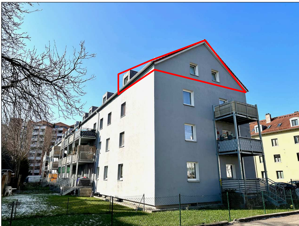
Foto 2 Ansicht von Süden
