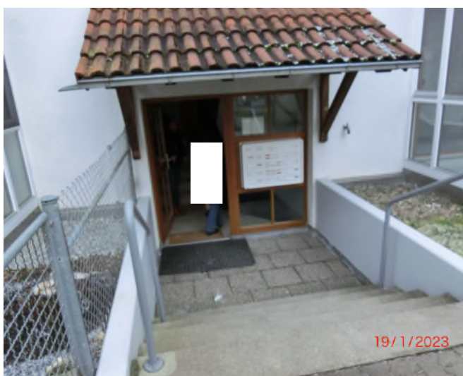
... mit herabführender Eingangstreppe zum Hauseingang von Haus 4
