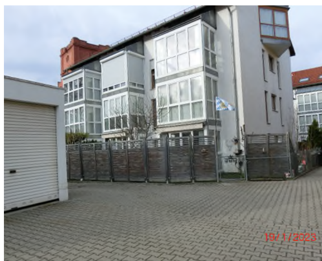
... und Blick auf "Haus 1" der Wohnanlage nahe der Doppelparker
