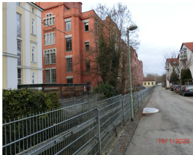
Blick entlang der Singold (Absturzschutz Zaunanlage) in die Apprichstraße in nördliche Richtung
