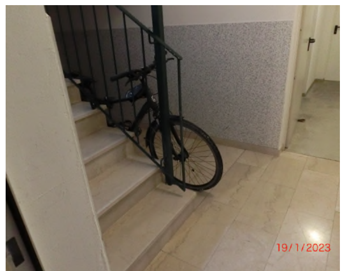
Treppenhaus, Treppenabgang in das Kellergeschoss
