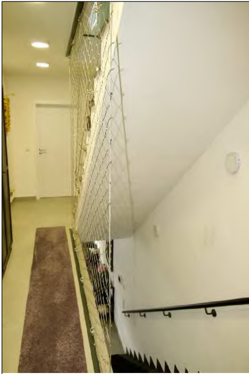
Foto 13 1. Obergeschoss - Flur, provisorische Absturzsicherung an Treppe
