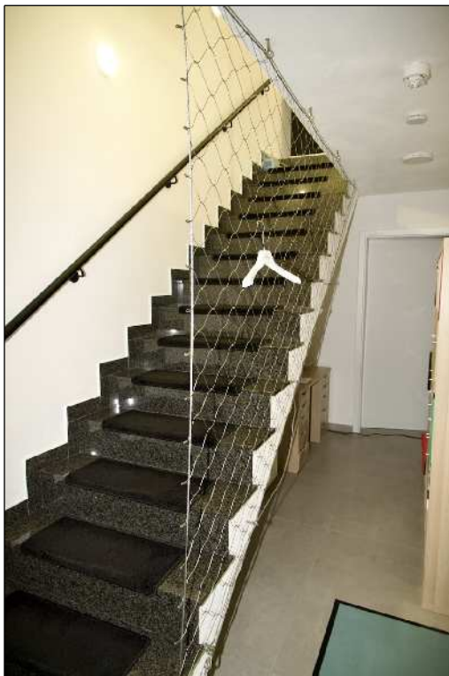
Foto 18 Kellergeschoss - provisorische Absturzsicherung
