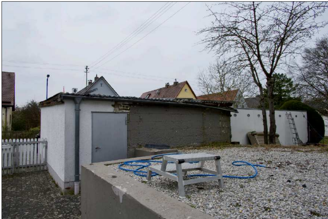
Foto 19 Garage - Ansicht von Norden
