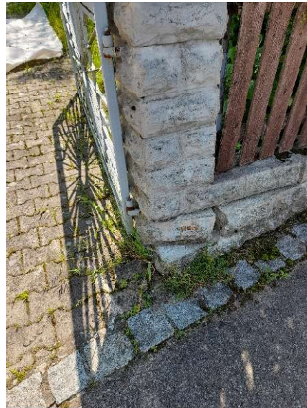
beschädigtes Zaunfundament
