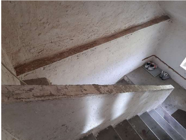
DG – Treppenaufgang zur DG-Wohnung
