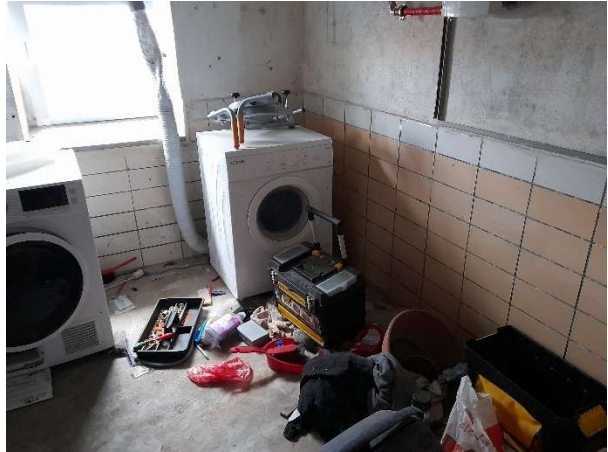
KG – Lager - Beschädigtes Inventar
