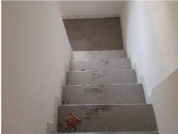
KG - Abgang zum Kellergeschoss
