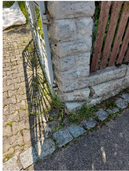
beschädigtes Zaunfundament
