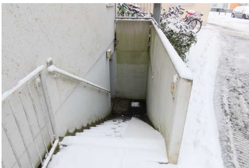
Kelleraußenzugang mit Fahrradrampe
