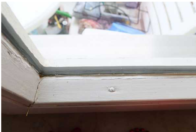
Holzisolierglasfenster bauzeitlich, Zustand
