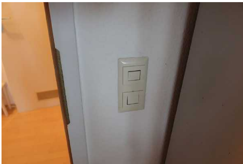
Elektroarmaturen, Ansicht u. Zustand
