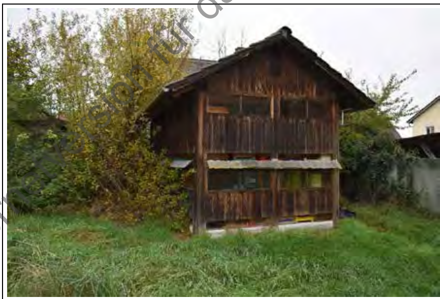
Foto 35: Bienenhaus, Blick von Ost
