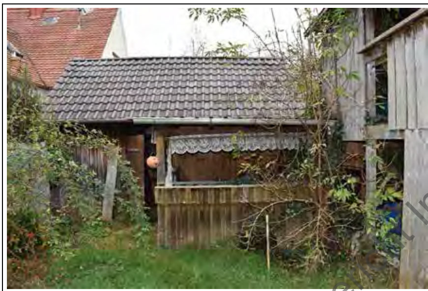
Foto 34: Holzhütte und Gartenlaube, Blick von West
