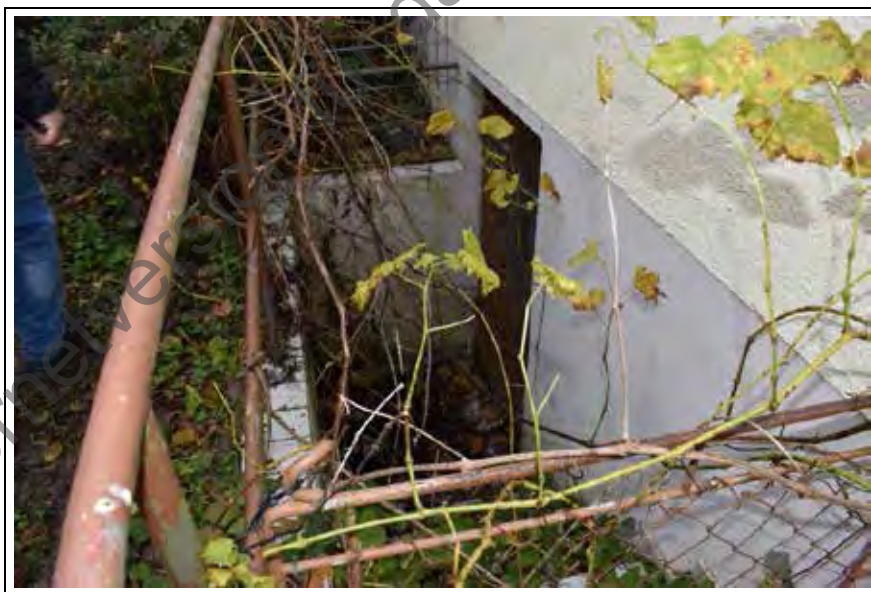
Foto 33: außen liegender Kellerabgang
