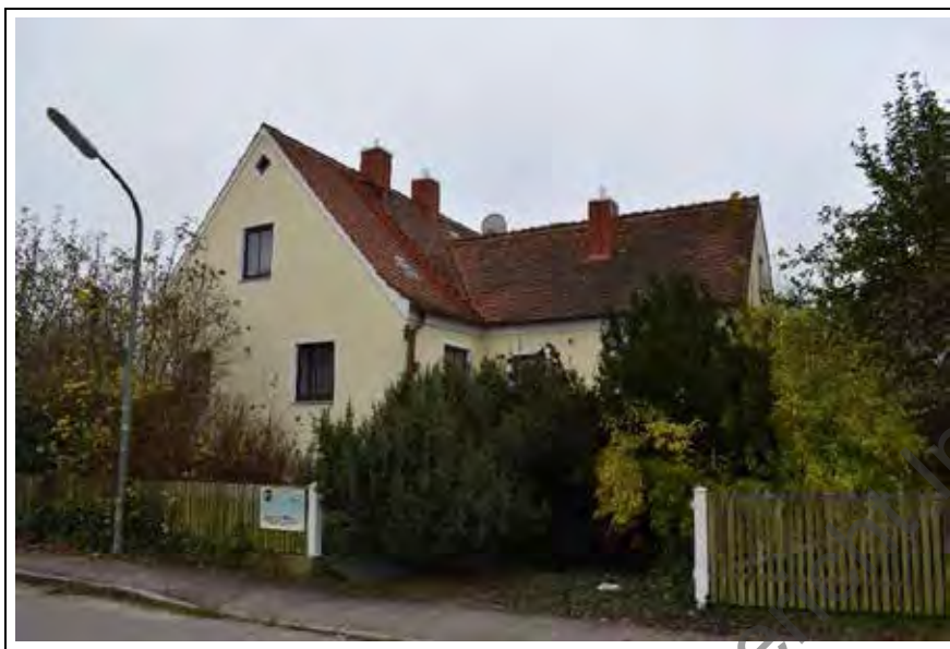
Foto 3: Straßenansicht von Nordwest
