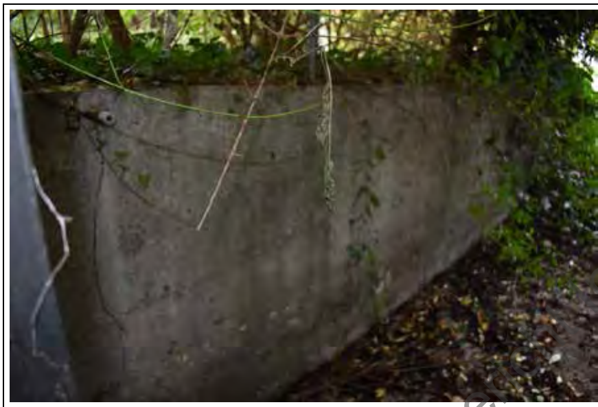
Foto 32: Abfahrt zur integrierten Garage / Stützmauer
