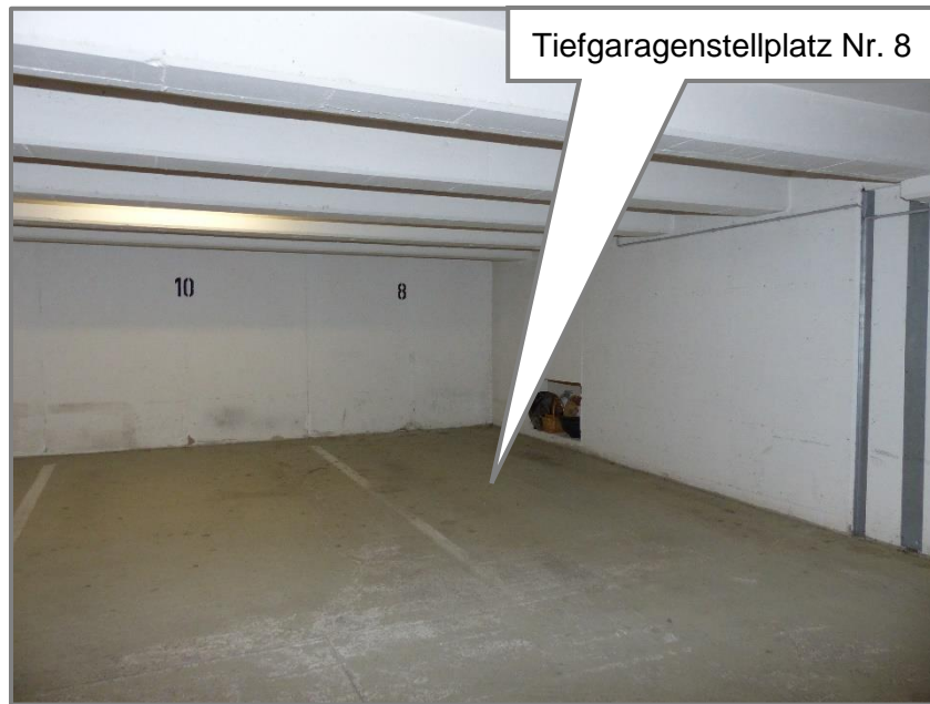
Tiefgarage – Tiefgaragenstellplatz Nr. 8
