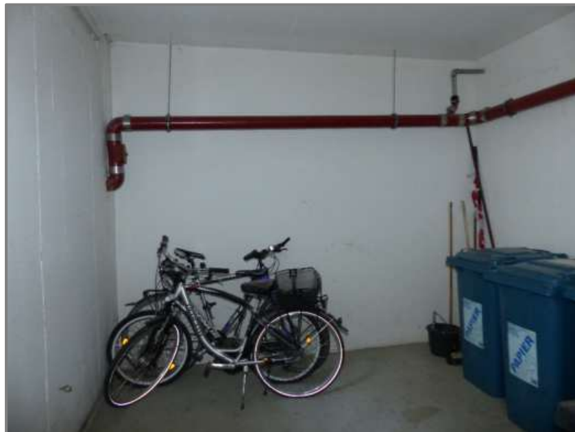
Kellergeschoss (Haus Nr. 5) - Müll
