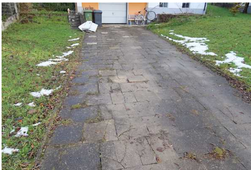
Einfahrt, Zustand (Setzungen, gebrochene Platten)
