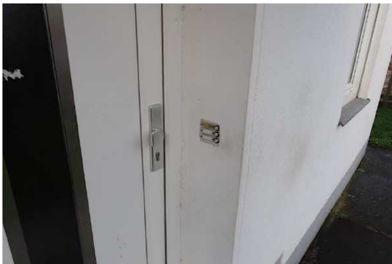
Klingelanlage, ohne Türsprechanlage
