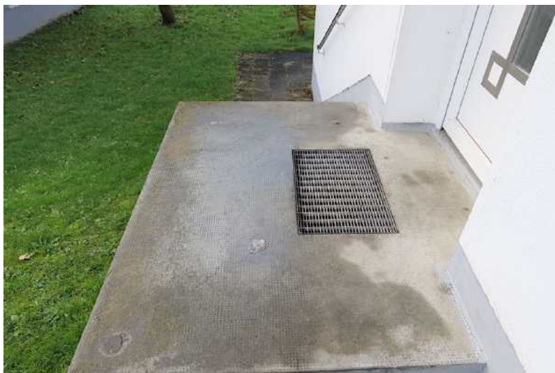
Eingangspodest ohne Absturzsicherung, Geländer fassaden- seitig
