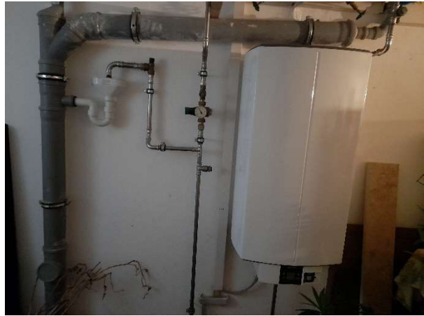
KG – Warmwasser-Wandspeicher
