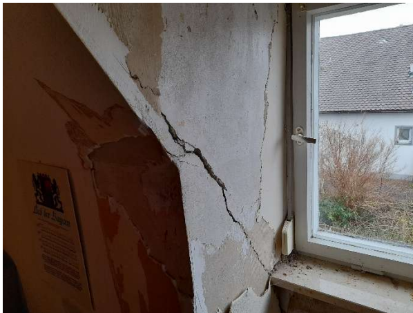
DG – Riss im Putz der Dachgaube
