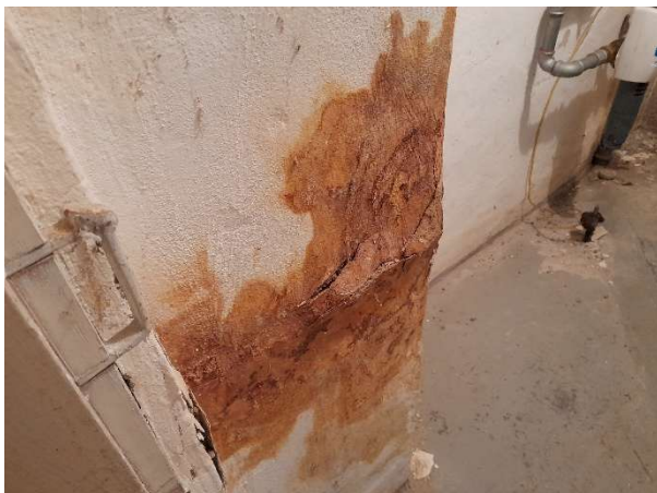
KG – Feuchtigkeitsschäden an Schornstein
