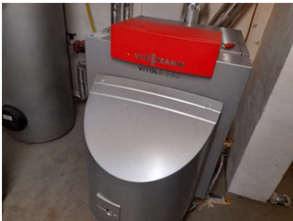
KG – Öl-Heizung mit Warmwasserspeicher
