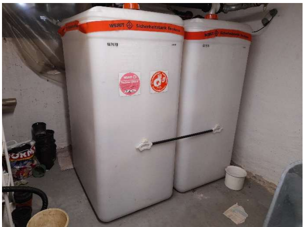
KG – Sicherheitsöltanks
