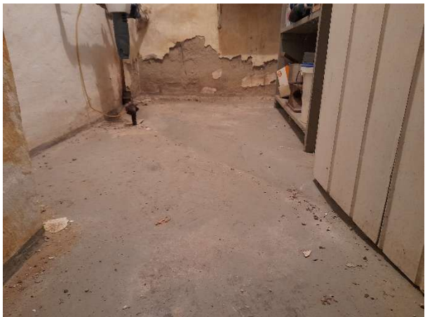
KG – Feuchtigkeitsschäden an Kellerwände
