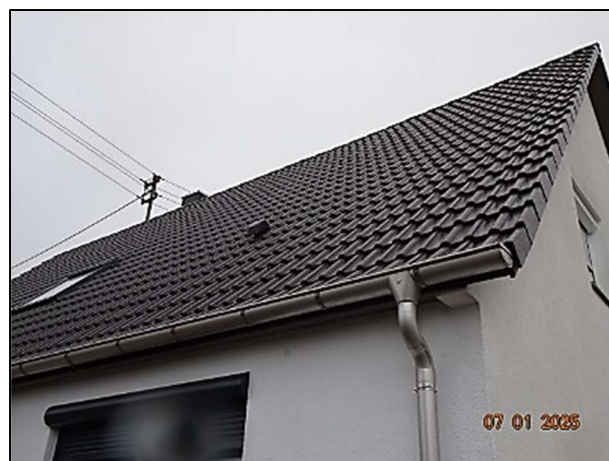
Dachdeckung Betonpfannen
