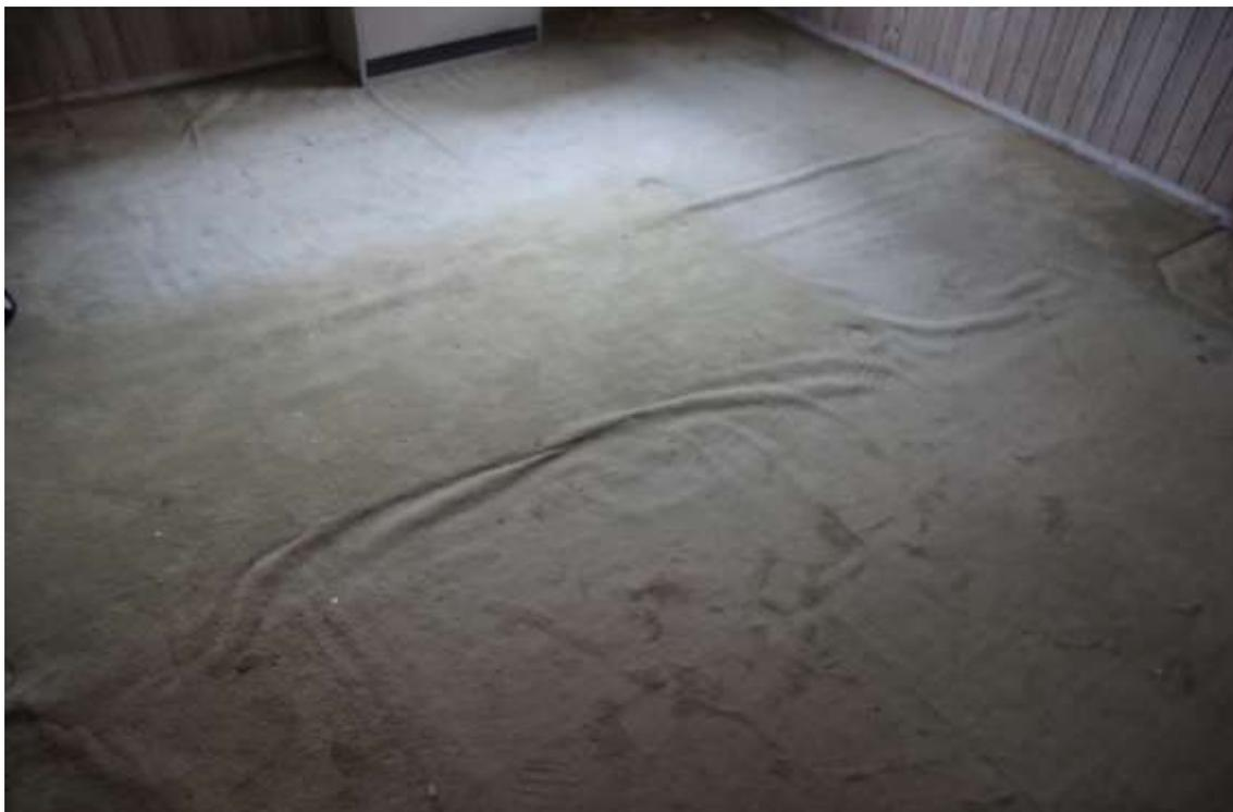
Detailansicht Bodenbelag mit Abnutzungs- und Verschleißerscheinungen
